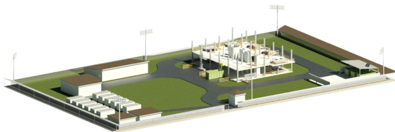
Рис. 1. Общий вид строительной площадки
