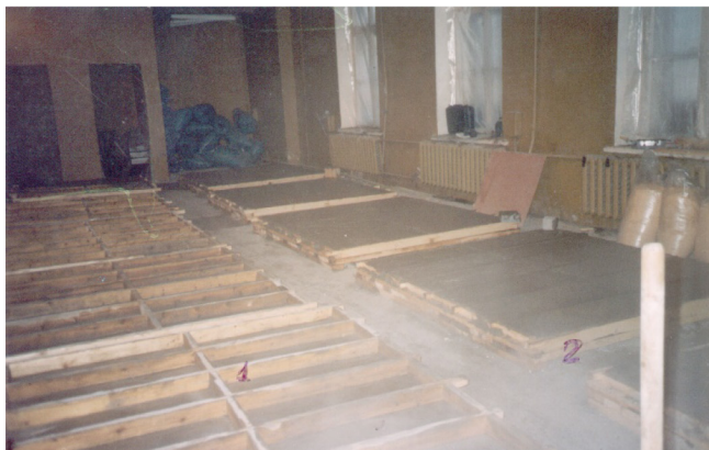
Рис. 2.16. Приготовление плит перегородок из АЛБ в построечных условиях: 1 – формы для изготовления плит 900 \times 600 \times 80 мм; 2 – формы, заполненные АЛБ-смесью
