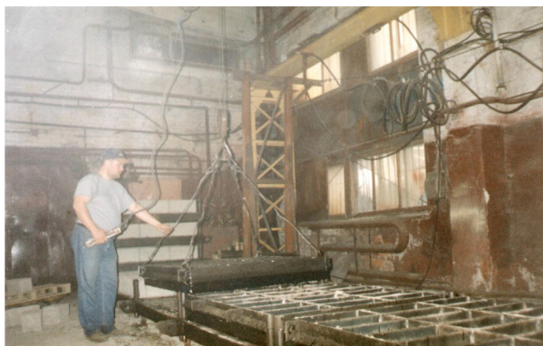
Рис. 2.10. Установка съемных рамок на поддоны с помощью тельфера
