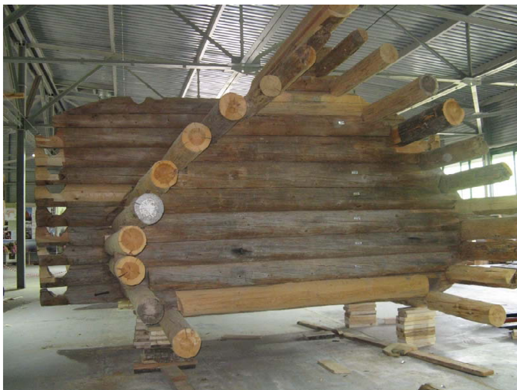
Рис. 4. Фрагмент церкви на сборочном участке
