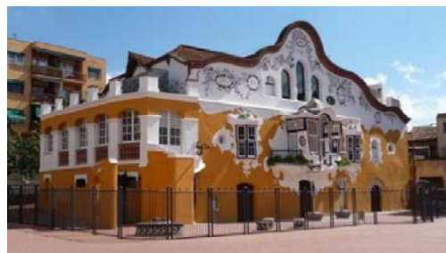
Рис. 3. Каса Негре, Барселона, арх. Ж. Жужоль, 1915–1926
