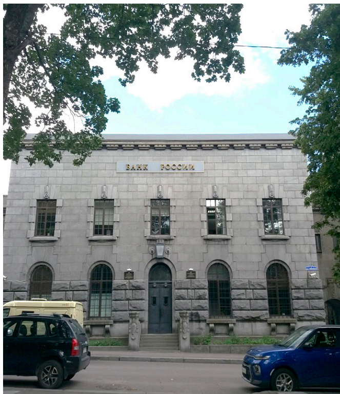
Рис. 2. Здание «Финляндский банк» («Центральный банк») (1912 г., Уно Вернер Ульберг; фото автора статьи, август 2021 г.)
