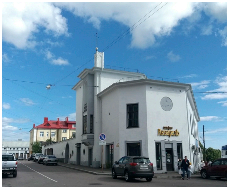
Рис. 5. Дом Вегелиуса (1926 г., Каарло Борг; фото автора статьи, август 2021 г.)
