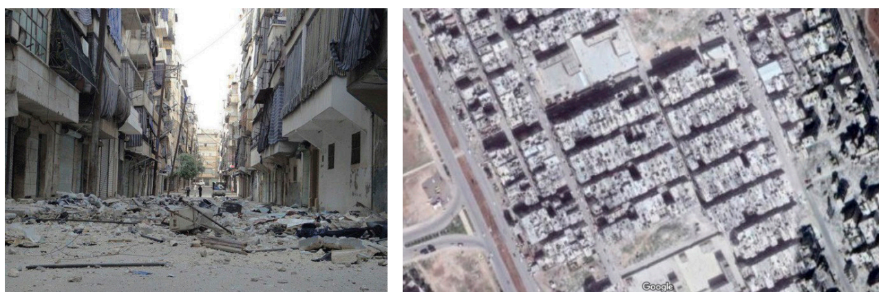
Рис. 14. Разрушения в Салах-эд-Дин
