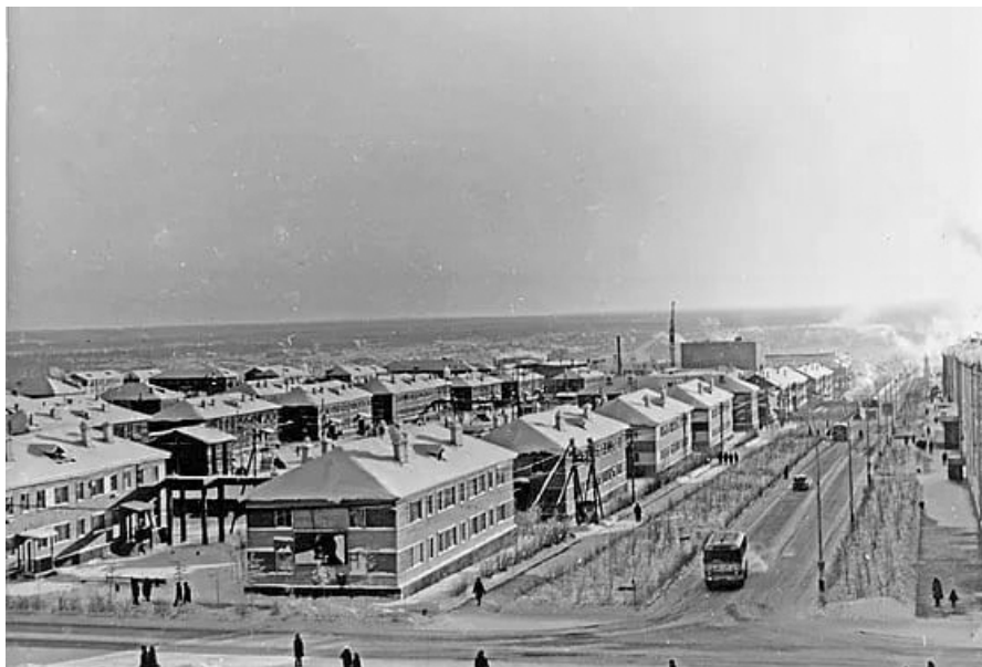
Рис. 3. Улицы 2-этажных домов: бревенчатых, обшитых деревянной доской, или щитовых домов первых «алмазных» годов постройки (1960–1970 гг.). В некоторых до сих пор отсутствует канализация
