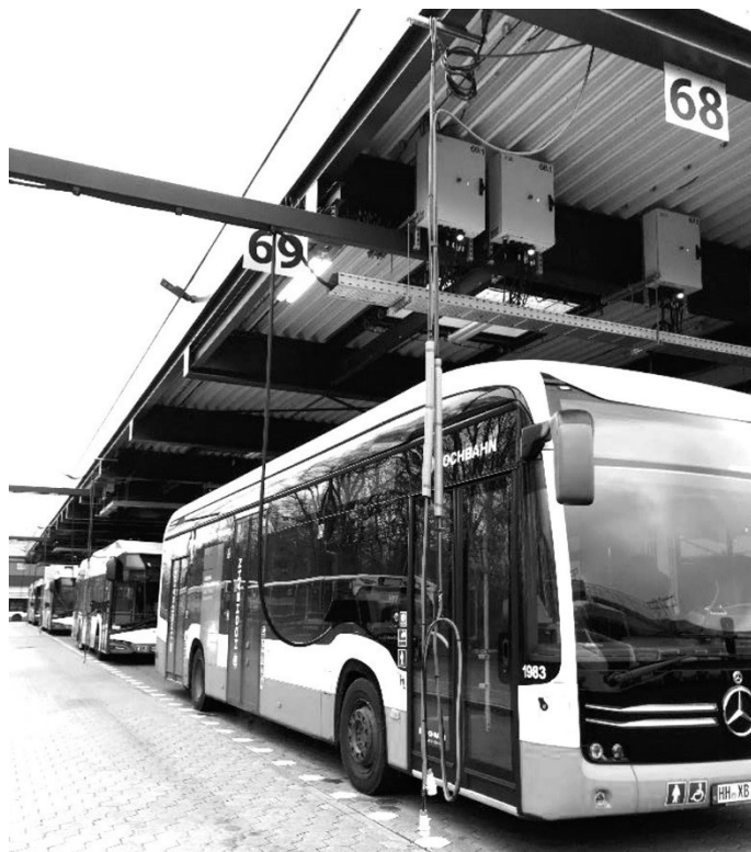
Рис. 6. Подключение к ЭЗС посредством кабельной сборки со стандартизированным разъемом (концепция длительной зарядки), при этом ЭЗС располагается выше зоны движения электробусов, под крышей навеса
