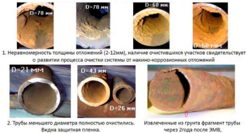
Рис. 8. Процесс очистки систем
