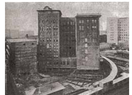
Рис. 5. Передвижка здания телефонной станции в Индианаполисе, США
