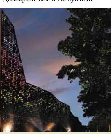
Мусоросжигательный завод в г. Роскилле
