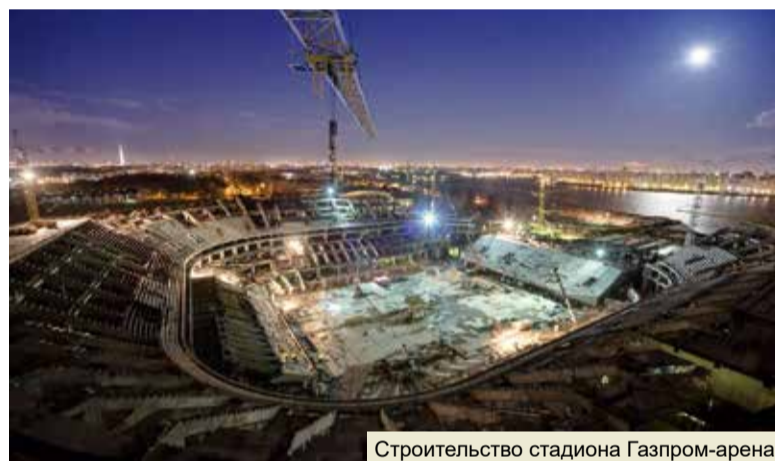
Строительство стадиона Газпром-арена
