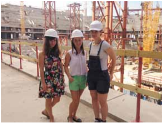
Строительство многих объектов в городе на Неве осуществляет ООО «Инжтрансстрой-СПб». Одним из масштабных сооружений, над которым в настоящее время ведутся работы, является стадион «Зенит-Арена».
