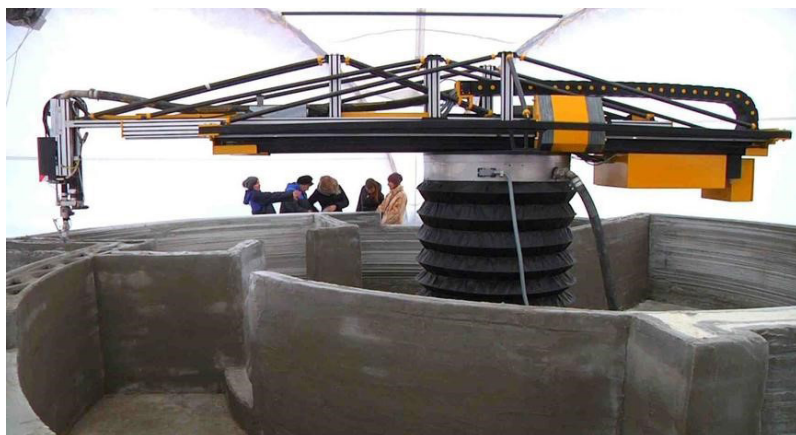
Рис. 6. Процесс печати стен [8]
