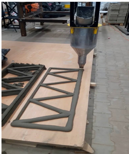
Рис. 2. Процесс печати отдельного блока стены с внутренней треугольной топологией (лаборатория БГТУ им. В. Г. Шухова)
