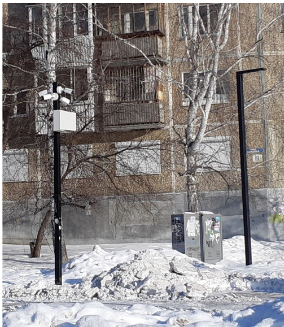
Рис. 2. Дублирование опор для видеокамер и уличных светильников. Фото автора
