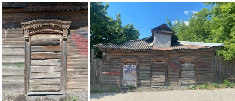
Рис. 2. Окно и фасад дома 132, ул. Введенская г. Рязани
