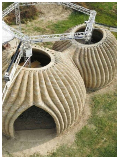
Рис. 6. Сооружения из глины, изготовленные методом 3D-печати [7]
