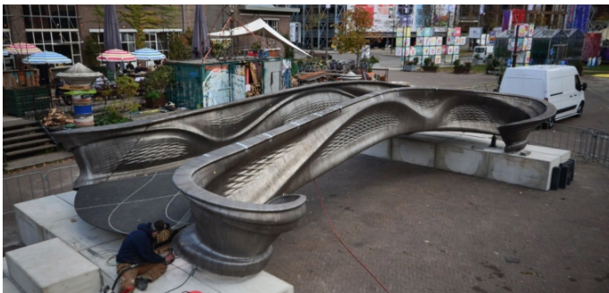
Рис. 4. Металлический мост, изготовленный методом 3D-печати [5]
