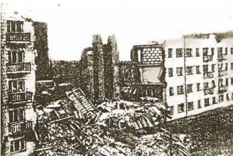
Обрушение кирпичного дома, строящегося в зимний период (рис. из книги Б. А. Сендерова)
