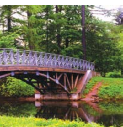
Арочный пешеходный мост из новых облегченных древесно-пластиковых труб в ЦПКиО им. Кирова. Проект разработал к.т.н. доц. каф. МТ А. М. Димов
