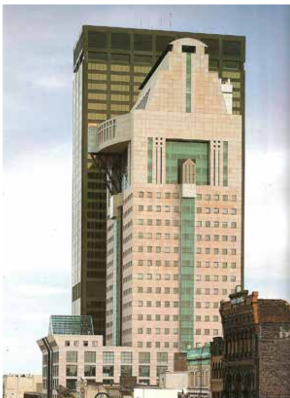
6. Здание медицинской корпорации в Луисвилле (США). Архитектор М. Грейвз. 1983–1986
