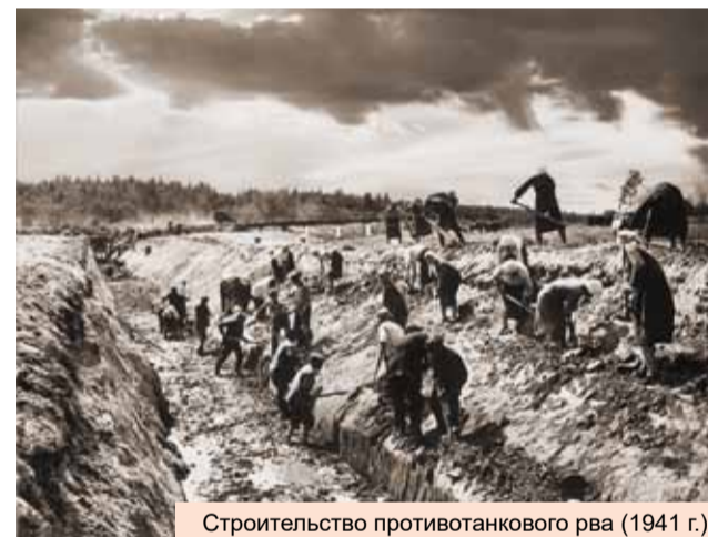
Строительство противотанкового рва (1941 г.)
