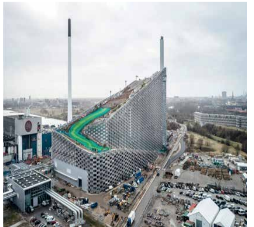
Мусоросжигательный завод в Копенгагене
