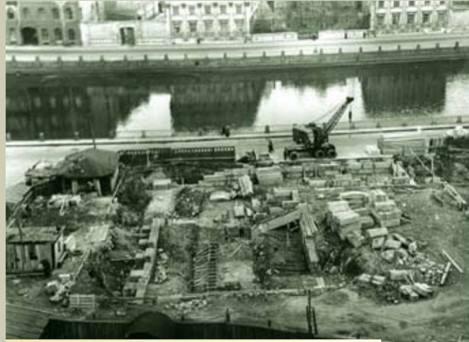
Строительство общежития на наб. р. Фонтанки, 123. Укладка блоков подвального этажа
