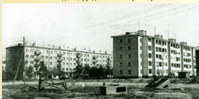
Ташкент. Жилые дома, фундаменты которых строил ССО ЛИСИ
