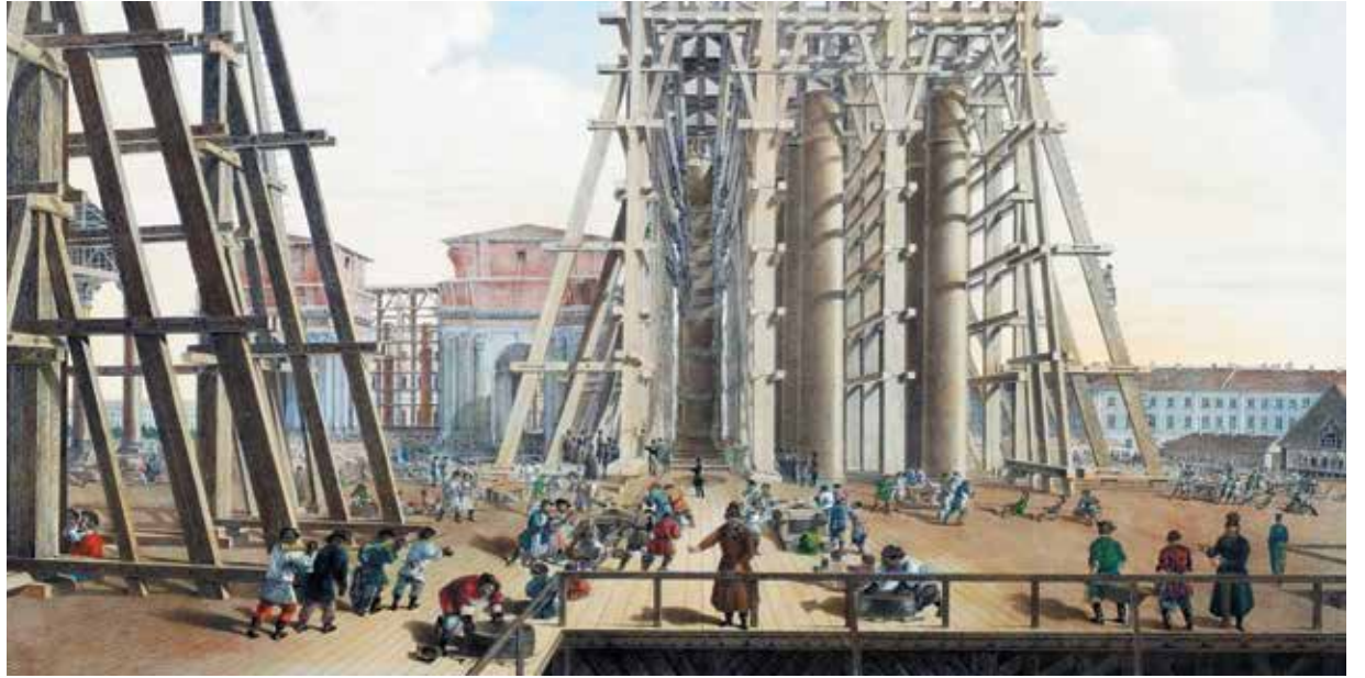
Возведение колонн Исаакиевского собора
