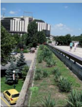
Пешеходный мост влюбленных
