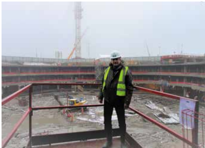
Р.А. Мангушев на фоне котлована Лахта-центра
