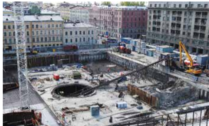
Производство работ методом «top-down» на строительстве новой сцены Мариинского театра
