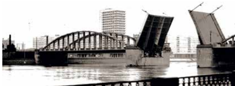
Старый мост в эксплуатации
