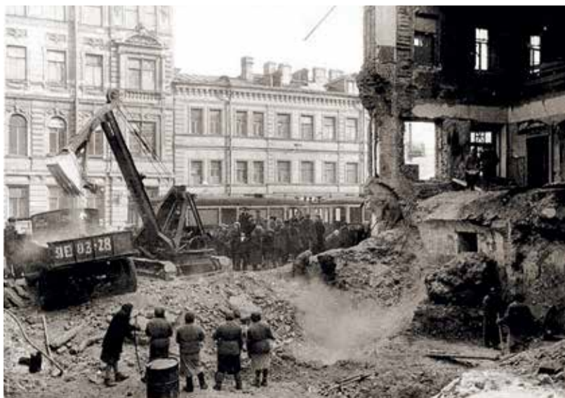
Разбор завалов разрушенного дома
