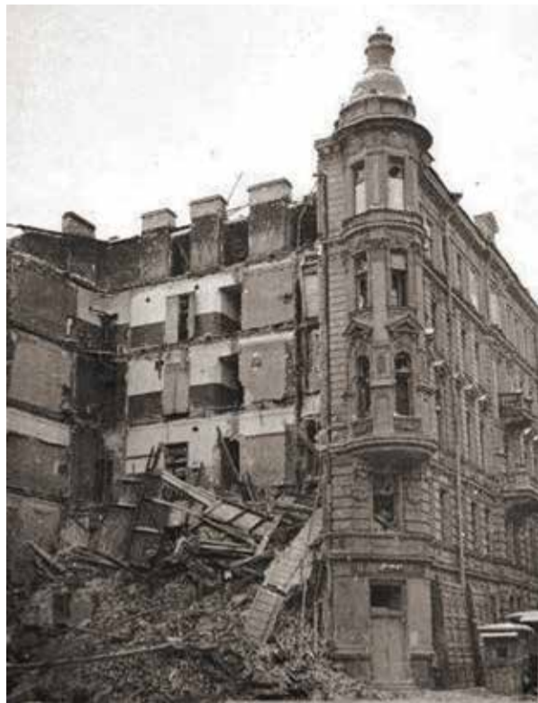
Обвалившаяся стена доходного дома
