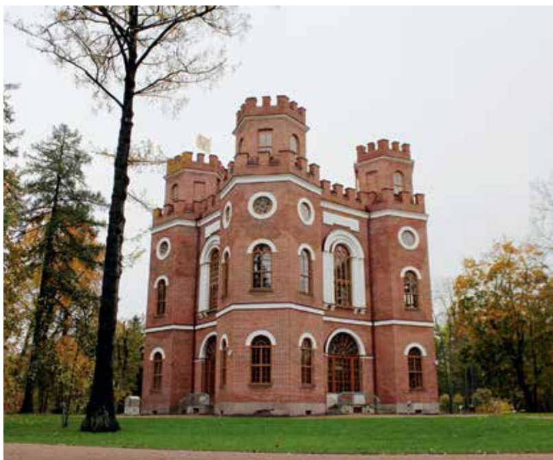
Павильон Арсенал после реставрации
