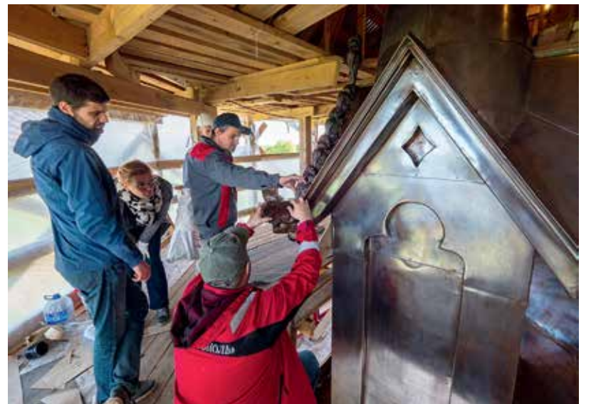
Павильон Шapelь. Монтаж выколотного декора. Фото Р. Шамукова
