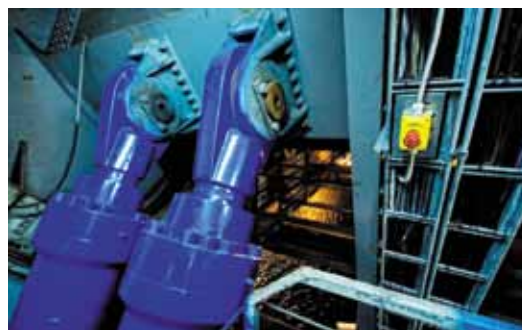
Гидравлические цилиндры Благовещенского моста
