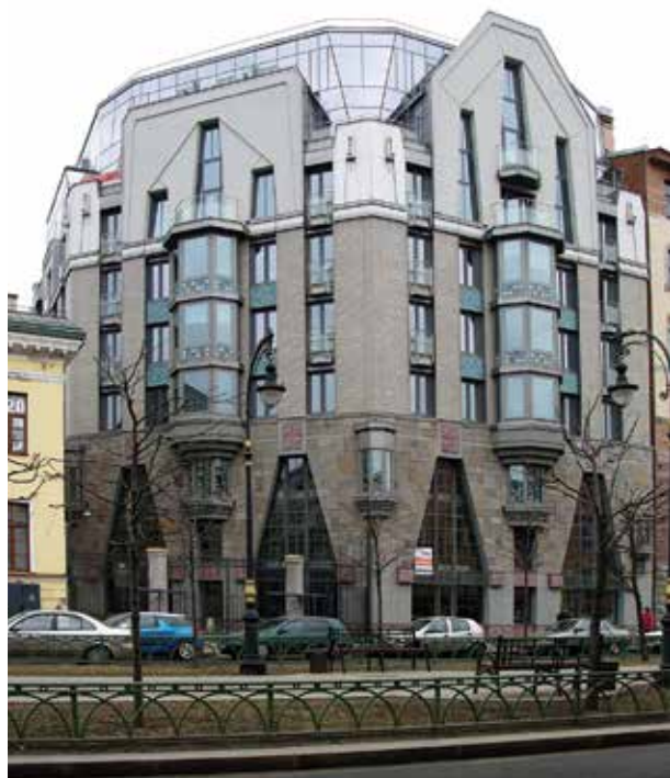
12. Жилой дом «Таврический». Пр. Чернышевского, 4 А. ООО «АПЦ Мамошина»
