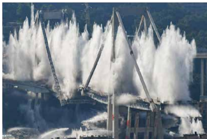
Виадук Моранди в момент его демонтажа
