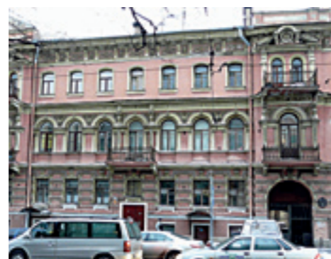
Особняк и доходный дом Е. Л. Осоргиной. Ул. Чайковского, 18 (1876–1877).
