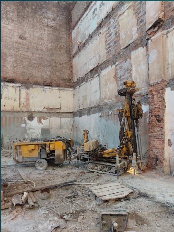
Усиление фундаментов соседних зданий
