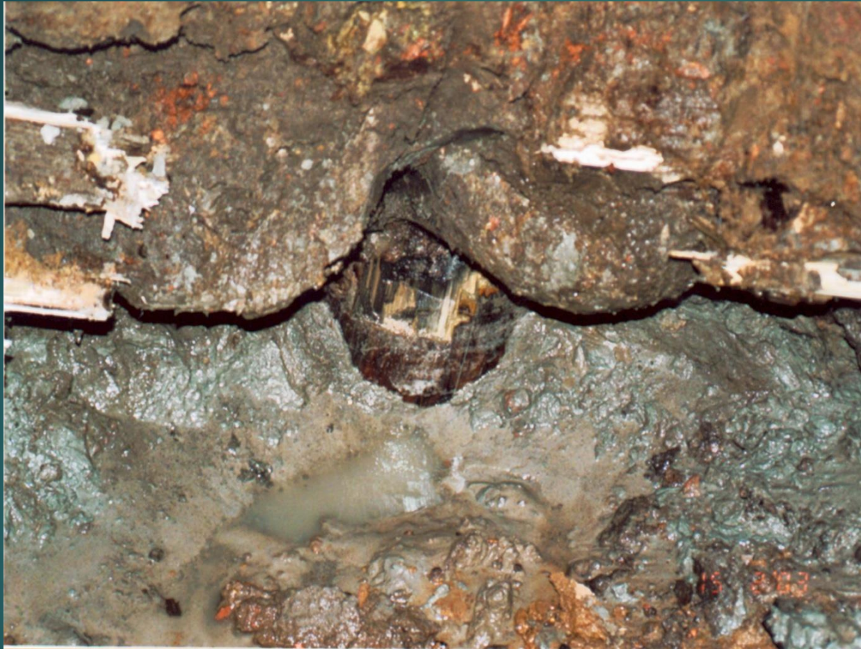
Общий Вид и образец деревянной сваи под подошвой фундамента в шурфе № 6 (по результатам обследования каф. Геотехники СПбГАСУ)
