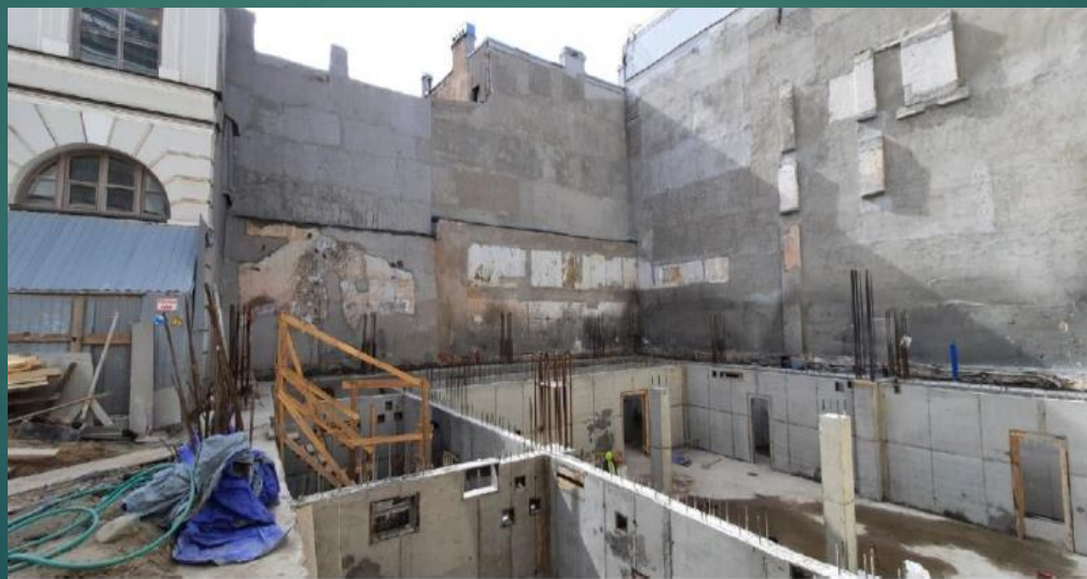
Технология устройства подземной части во внутреннем дворе дворца
