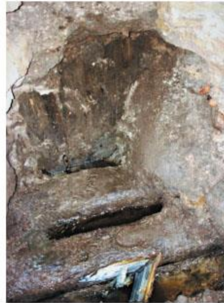
Общий вид лежней (a) и схема осадки фундамента при гниении лежней (б)
