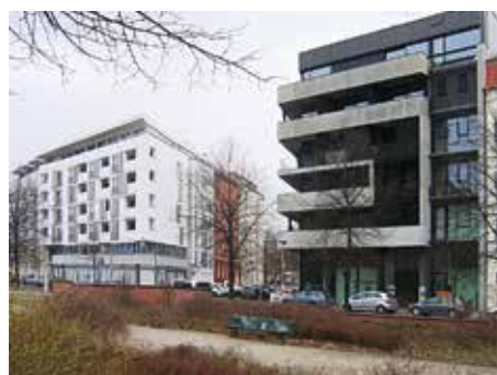
Passivehaus (пассивный дом) на улице Engeldamm – пример новой устойчивой архитектуры города
