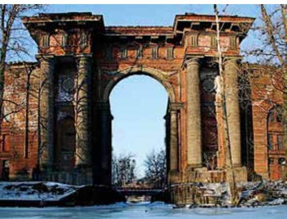
6. Арка Новой Голландии. 1779–1787 гг. Сооружение триумфальных арок всегда связывалось с военными победами. Но устройство такой арки в периметре кирпичных стен складского комплекса романтизировало важную для города утилитарную функцию, придавало всему комплексу некое имперское величие
