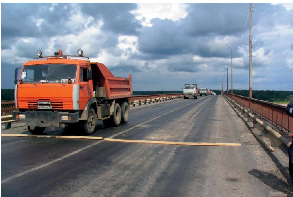
Рис. 4. Динамические испытания режимов фактической нагруженности конструкций СТЖБ ПС автодорожного моста через реку Сысолу в Республике Коми РФ
