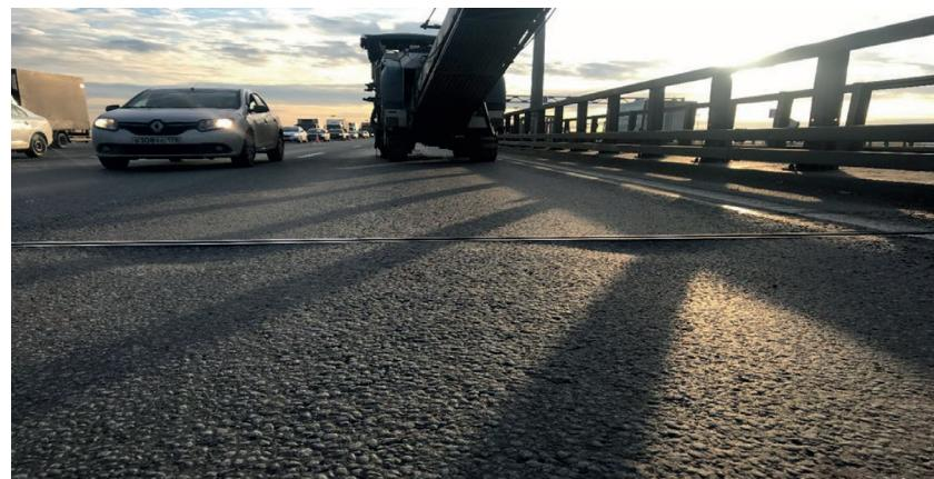
Рис. 1. Абразивный износ покрытия из ЩМА в переходной зоне
