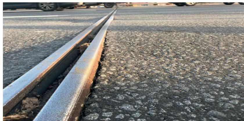
Рис. 2. Абразивный износ покрытия из ЩМА в переходной зоне
