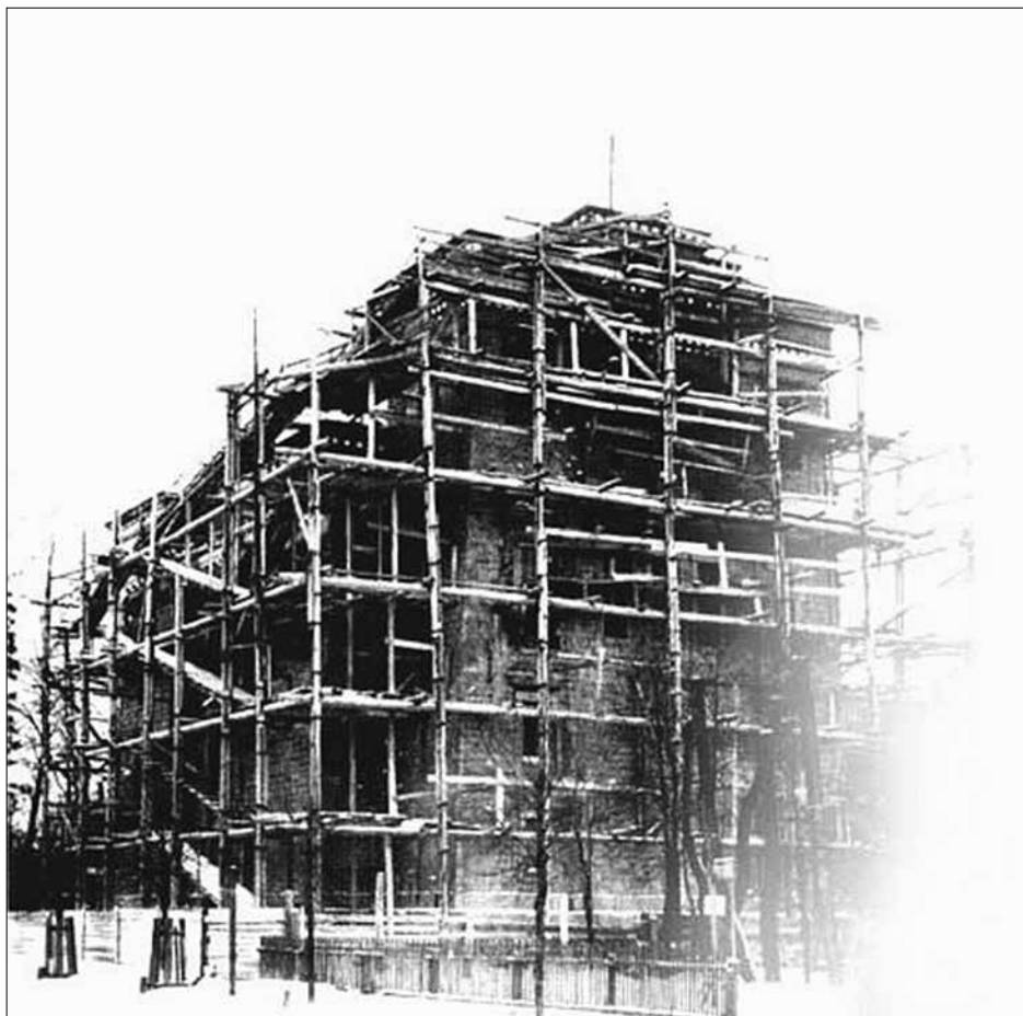
Строительство буддийского храма. 1913 г.
