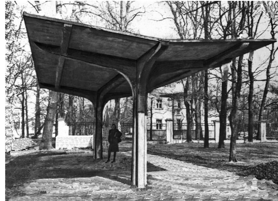
Железобетонный навес. Экспонат Товарищества «Железо-Бетон»
