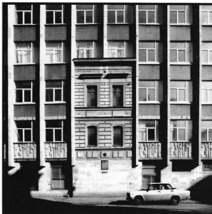
Фрагмент фасада архитектурного корпуса
