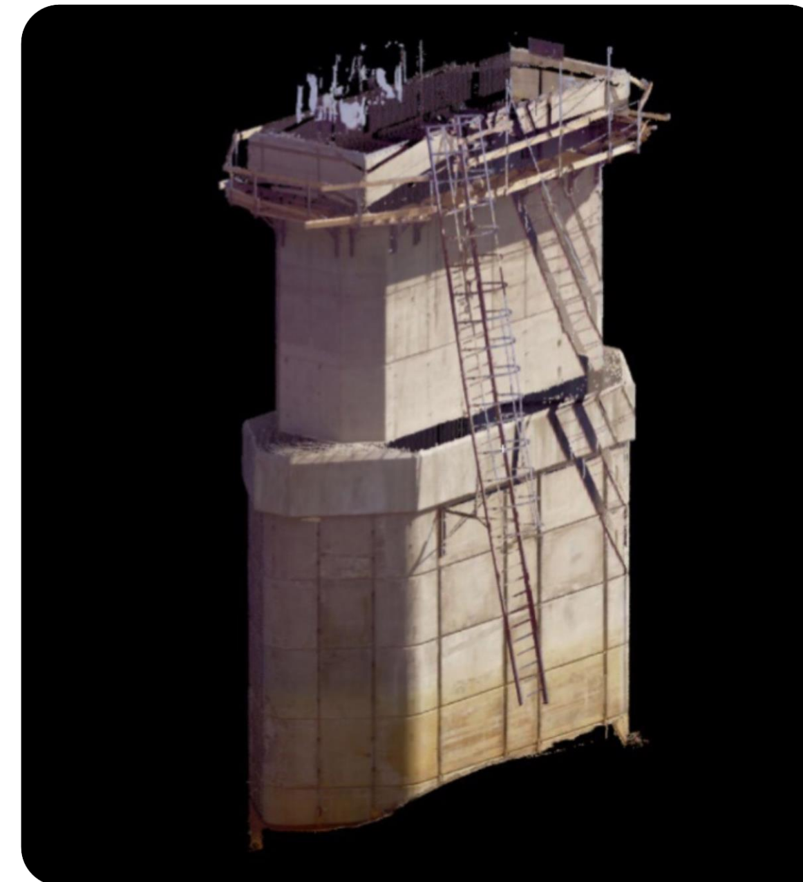
3. Опора №3 – облако точек (Результат сканирования)
