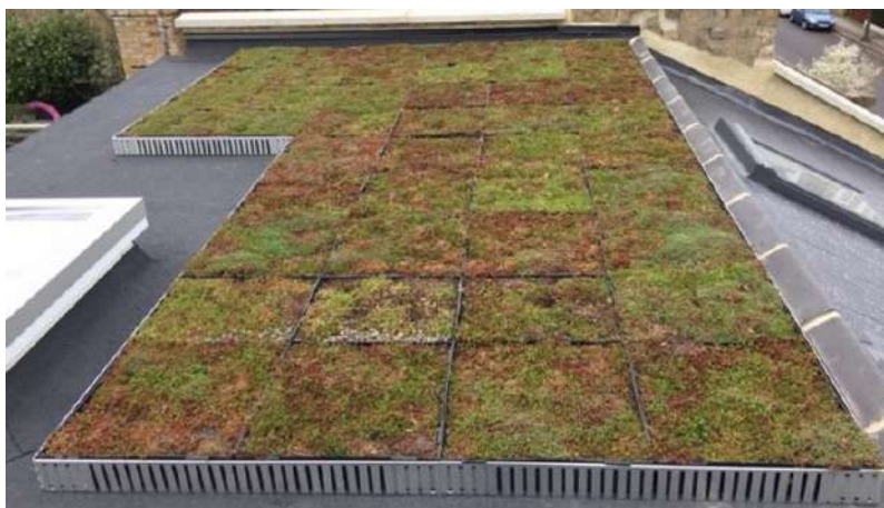
Рис. 1. Устройство модульной системы «зеленой» кровли [14]
