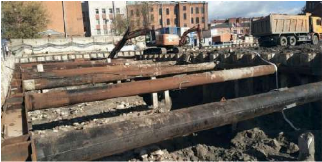
Рис. 2. Площадка строительства по адресу Санкт-Петербург, Аптекарский проспект
