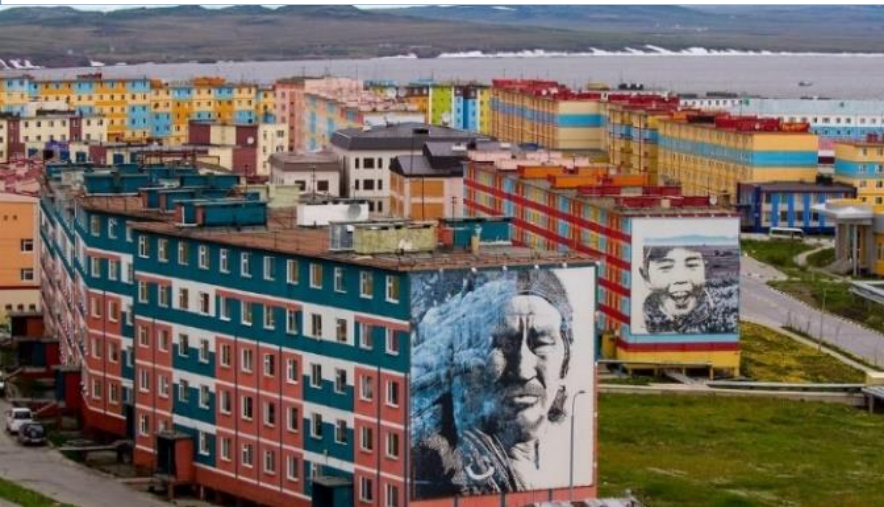
Россия, г. Анадырь. Реконструкция панельных домов ( https://анадырь.инфо.сайт )
