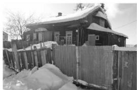
2. Здание гидрометеорологической обсерватории, в котором жил и работал Д.М. Чубынин
