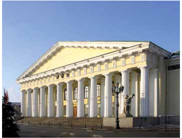
9. Горный институт. 1806–1811 гг. Безошибочное чувство места подсказало А. Н. Воронихину единственно правильное решение представить обращенный к Неве главный фасад здания в виде двенадцатиколонного портика самого мужественного и тектонически ясного дорического ордера
