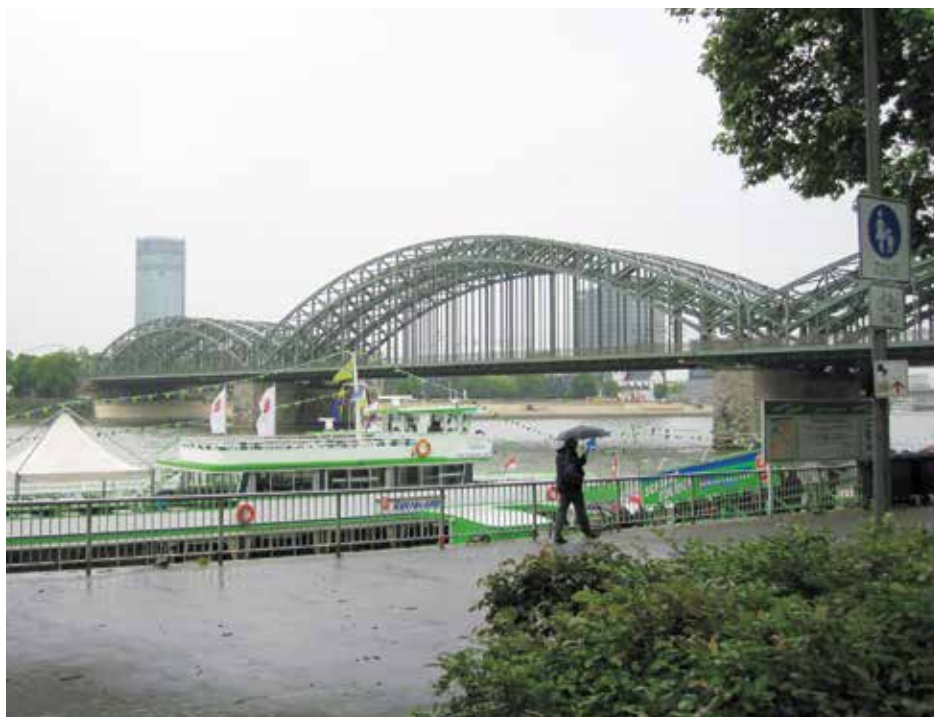
Мост Гогенцоллернов через Рейн в Кёльне
