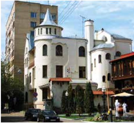
А. У. Зеленко. Доходный дом крестьянина П. В. Лоськова. 1905–1906. Москва, Мансуровский пер., 4, стр. 1. Современный вид
