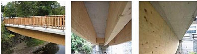
Рис. 3. Вид деревобетонного моста
