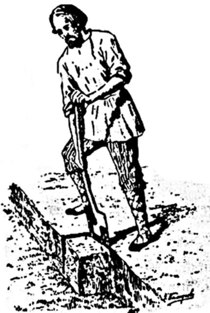
Разработка поверхностной залежи глины
