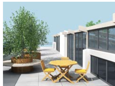
Вид на эксплуатируемую кровлю с теплицами
