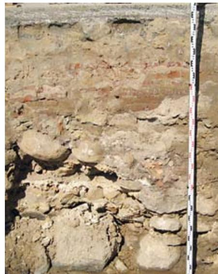
оказалось присутствие булыжного мощения под слоем асфальтобетона. Данное обстоятельство свидетельствует о восстановлении участков мощения после прокладки газопровода, а следовательно, и об отсутствии асфальтового покрытия Казанской улицы как минимум до 1950-х гг.
