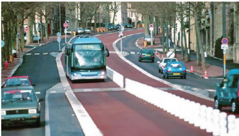
Рис. 5.4. Коридор для ГПТ с одной полосой для автомобильного транспорта (Руан, Франция)
