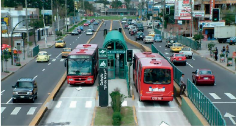
Рис. 5.3. Типичный коридор для ГПТ
