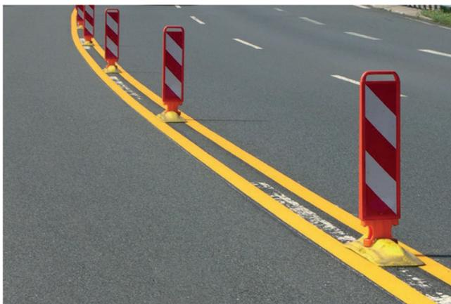
Рис. 5.9. Выделение полосы с использованием флажков
