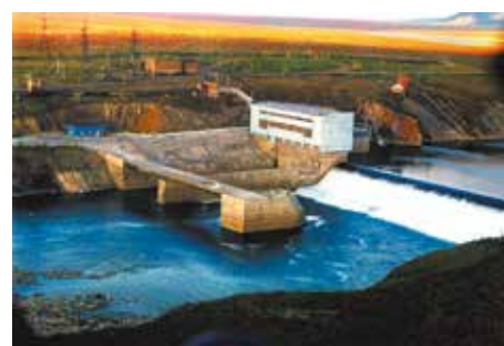
Плотина на р. Усе 2
