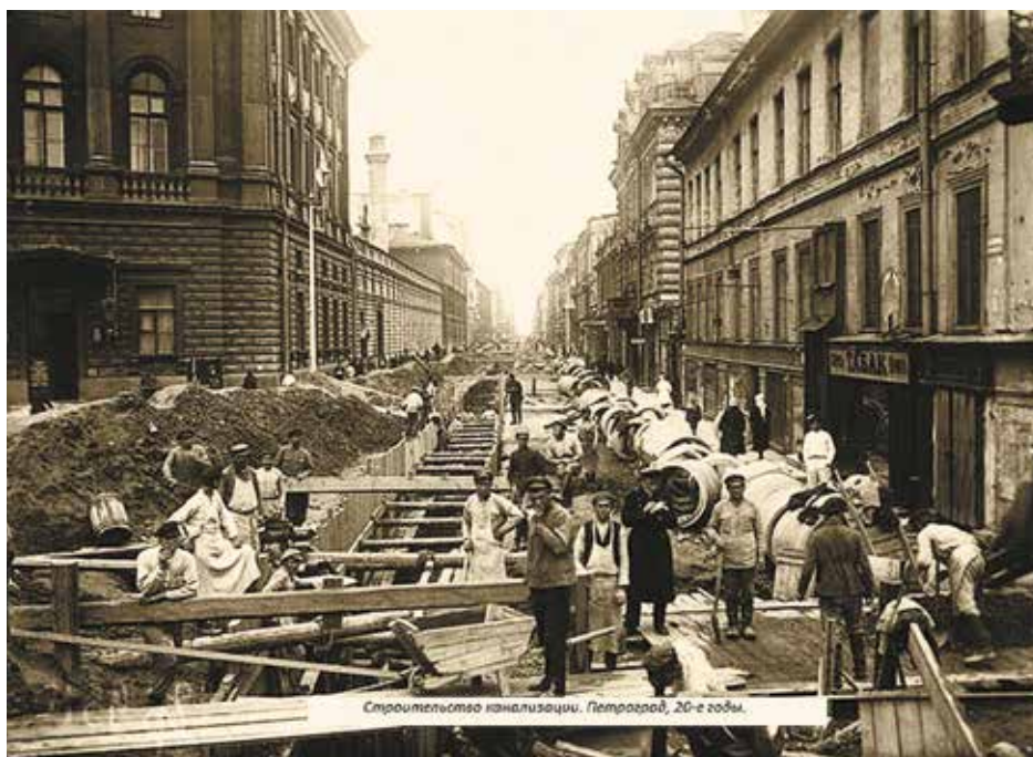
Строительство канализации в Петрограде. Первая половина 1920-х гг.
