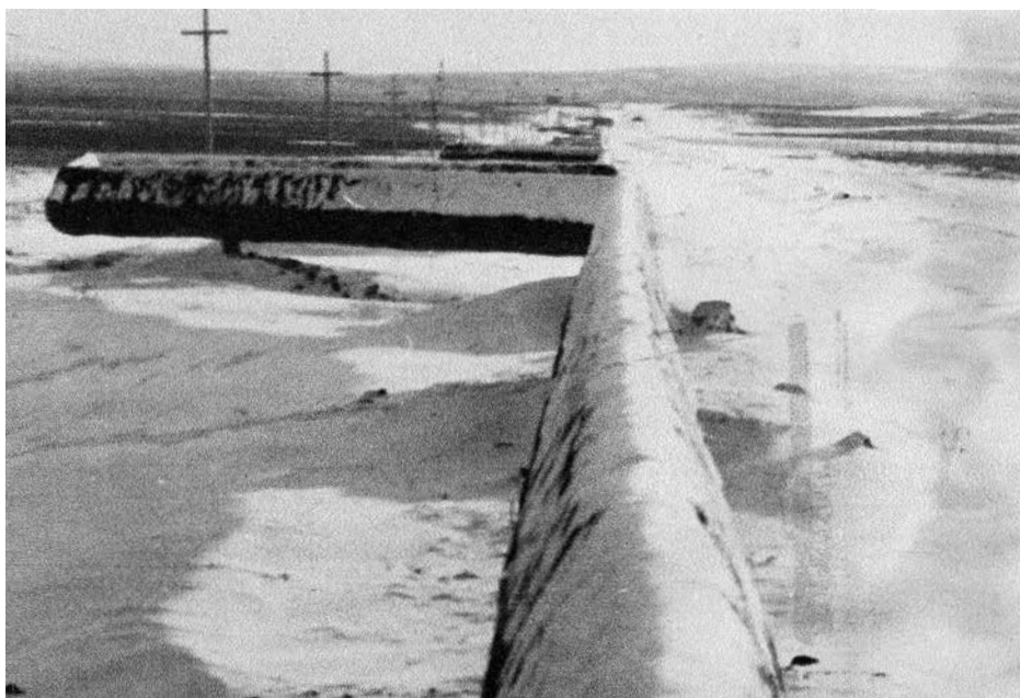
Водовод от плотины на р. Усе
