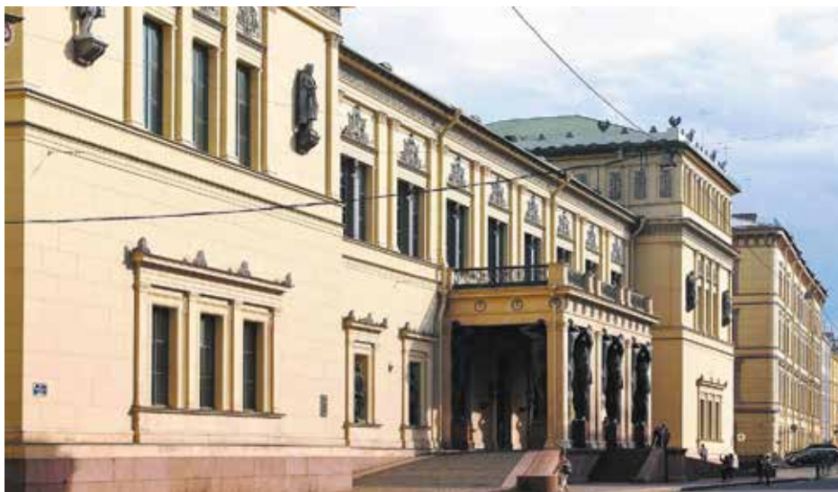
5. Здание Нового Эрмитажа. 1839–1852 гг.
