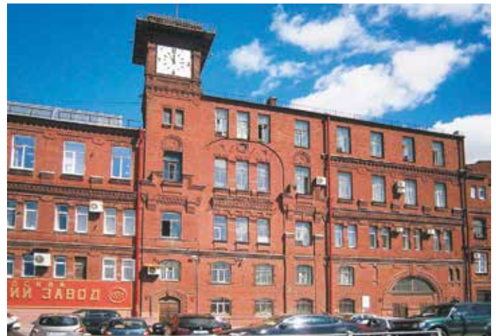
Административное здание Металлического завода (ныне филиал ПАО «Силловые машины»). Свердловская наб., 18. 1892–1893 гг.
