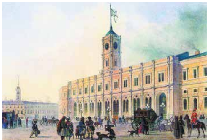
17. Санкт-Петербургская пассажирская станция. 1844–1851 гг. Акв. А. В. Петцольта. 1851 г.
