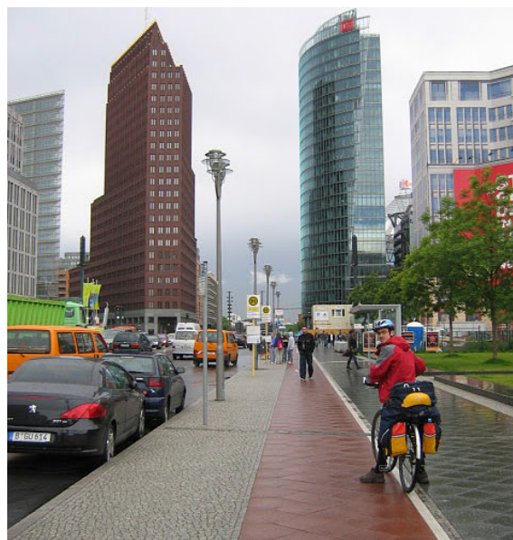
Рис. 2. Покрытие велосипедной дорожки крупной плиткой без фасок, Германия [3]
