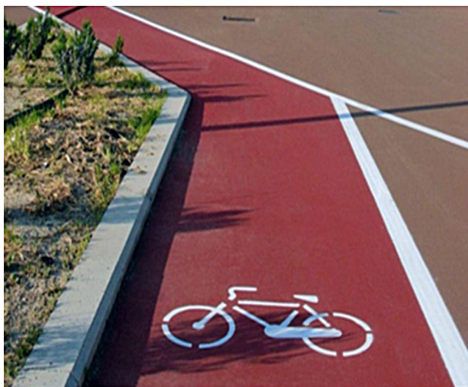
Рис. 6. Акриловое покрытие велосипедной дорожки [6]
