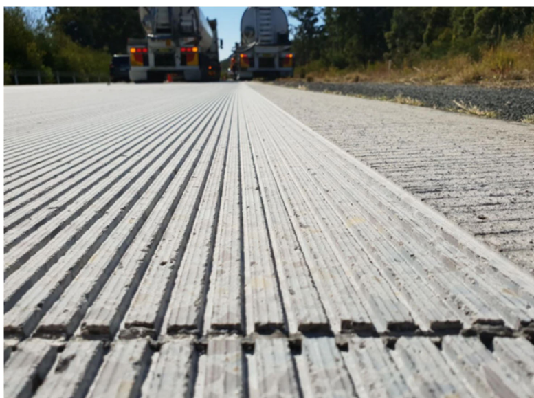
Комбинирование алмазного шлифования и нарезки борозд
