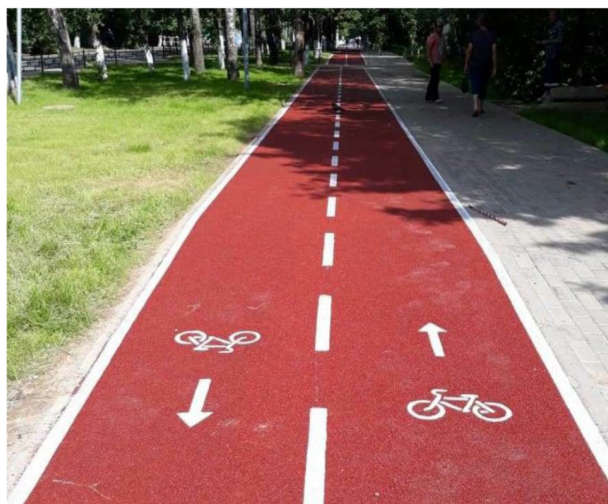
Рис. 8. Покрытие велосипедной дорожки из резиновой крошки [7]
