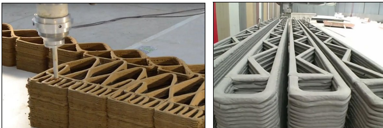
Рис. 1. Стеновые печатные конструкции ИЖС: слева – керамические, справа – бетонные
