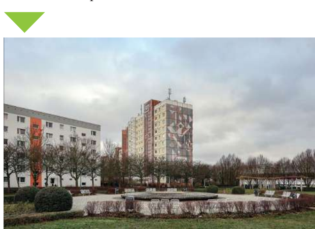
Рис. 6. Берлин. Kaulsdorf Plattenbau. Источник: https://www.tagesspiegel.de/berlin/architektur-in-berlin-marzahn-wir-koennen-uns-von-der-ddr-bauweise-eine-platte-abschneiden/24060726.html
