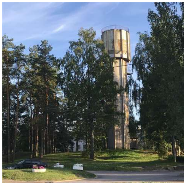
Рис. 3. Кирпичная водонапорная башня
