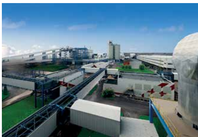
Новый цементный завод Группы ЛСР в Ленинградской области является одним из самых высокотехнологичных производств в мире
