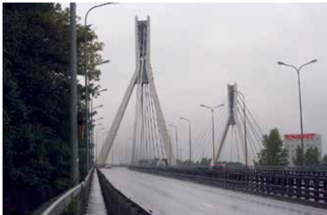
Пилоны путепровода из наномодифицированных бетонных смесей в створе пр. Александровской Фермы
