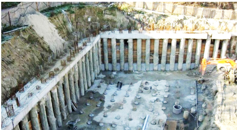
Рис. 2. Внешний вид подпорной стены из буронабивных свай
