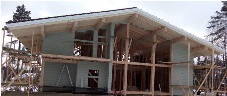
Рис. 3. Вид на здание в процессе производства СМР
