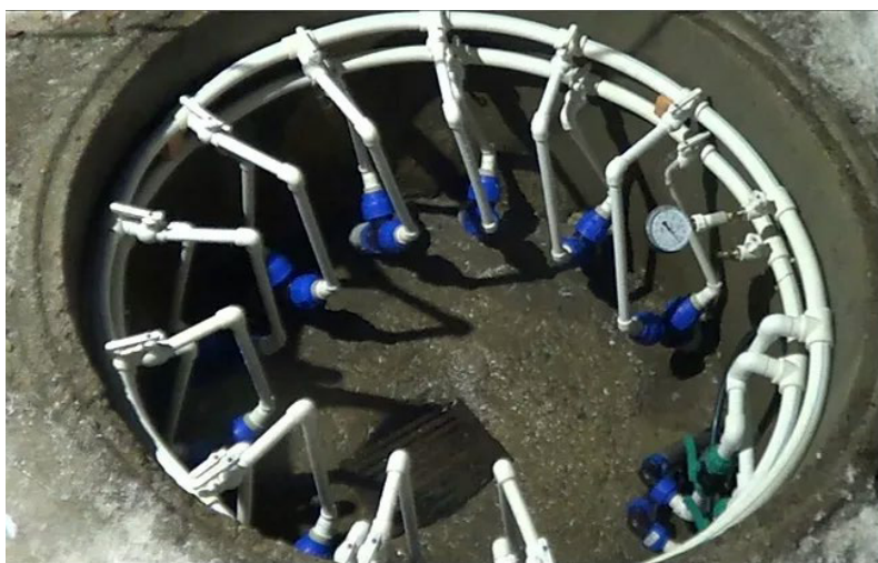
Рис. 7. Двухуровневый распределительный геотермальный коллектор
