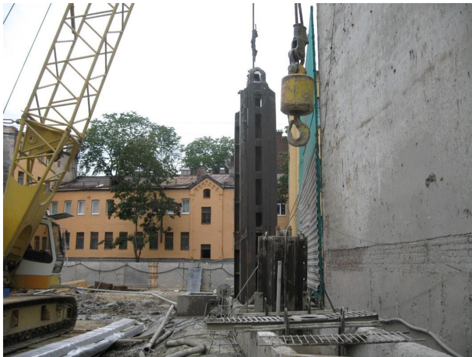
Рис. 4. Устройство ограждения котлована по технологии «стена в грунте»
