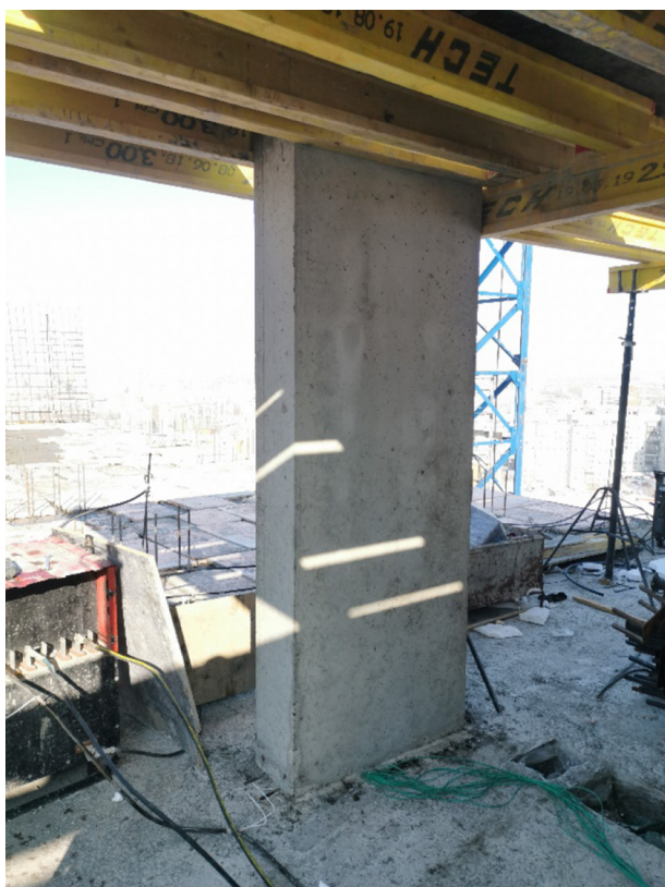
Рис. 7. Колонна сечением 300 \times 1200 мм после распалубки
