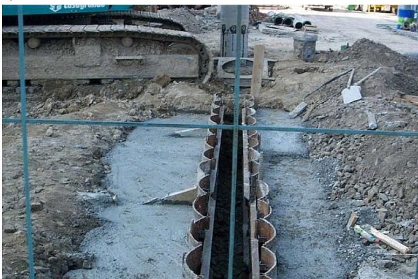
Рис. 7. Устройство форшахты для буросекущихся свай: а) съемная опалубка; б) несъемная опалубка
