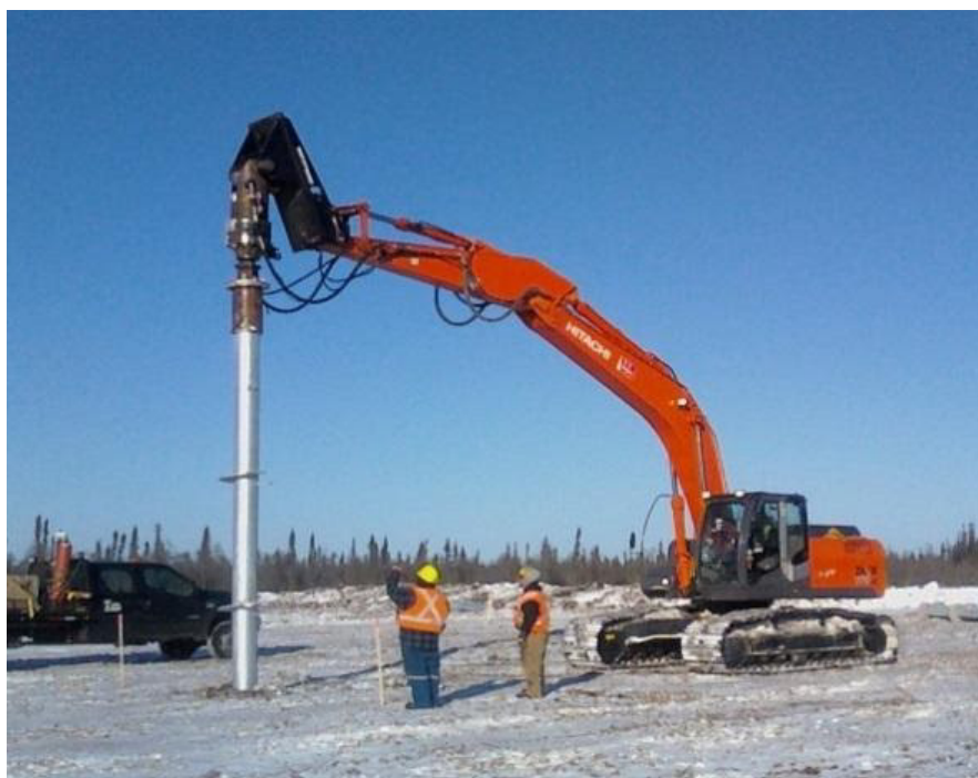
Рис. 5. Экскаватор с гидровращателем
