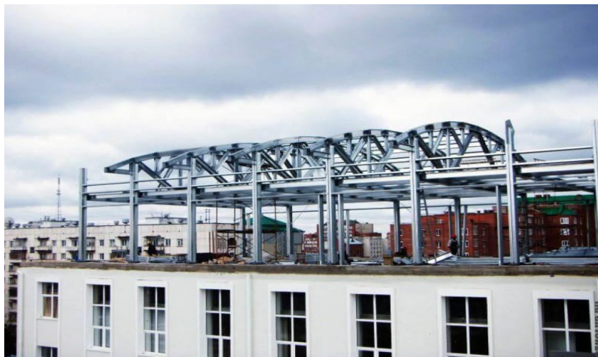
Рис. 3. Надстройка этажа по технологии ЛМК
