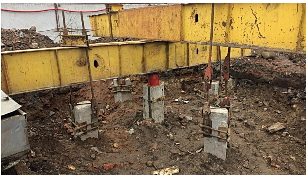
Рис. 5. Устройство анкерной системы балок для проведения статических испытаний грунтов вдавливающей нагрузкой
