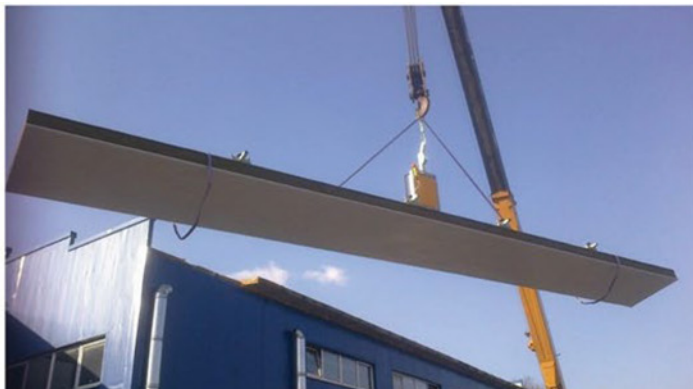
Рис. 10. Строповка сэндвич-панелей при горизонтальной раскладке: а – схема строповки; б – монтаж панели
