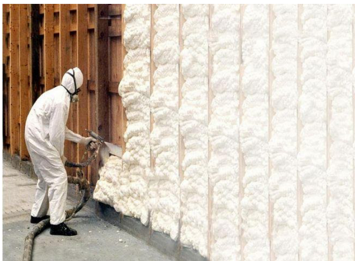
Рис. 7. Утепление наружных стен напылением
