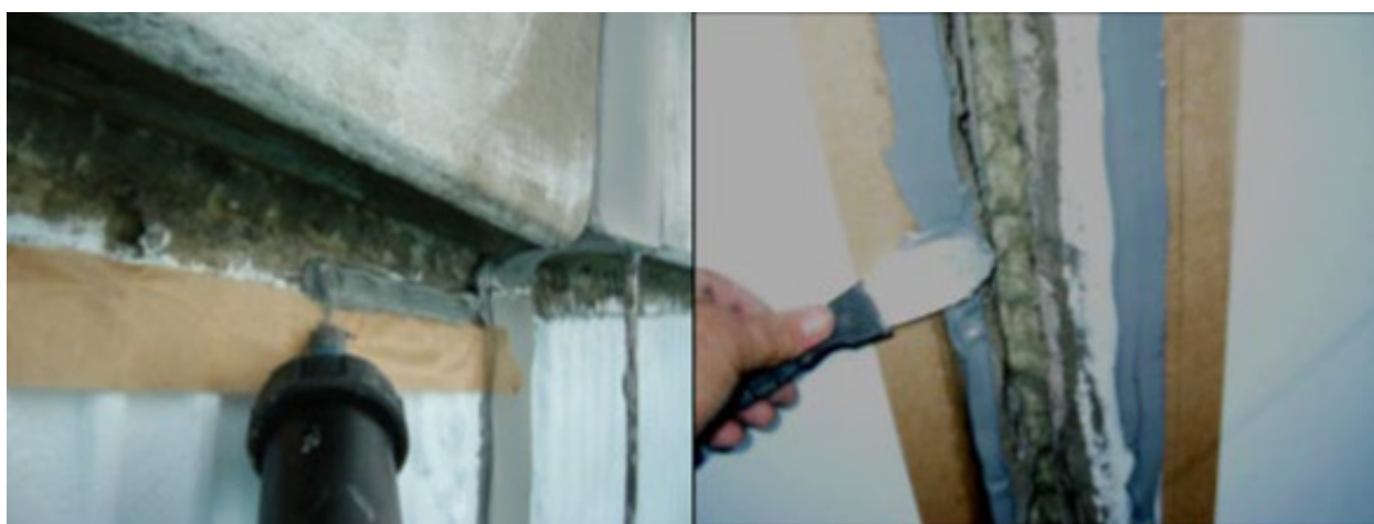
Рис. 7. Нанесение клейкого состава
