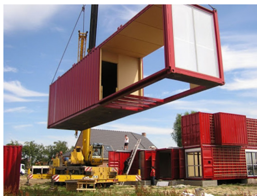
Рис. 4. Использование автокрана для монтажа контейнеров
