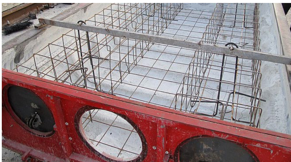
Рис. 1. Армирование и опалубка универсальной панели
