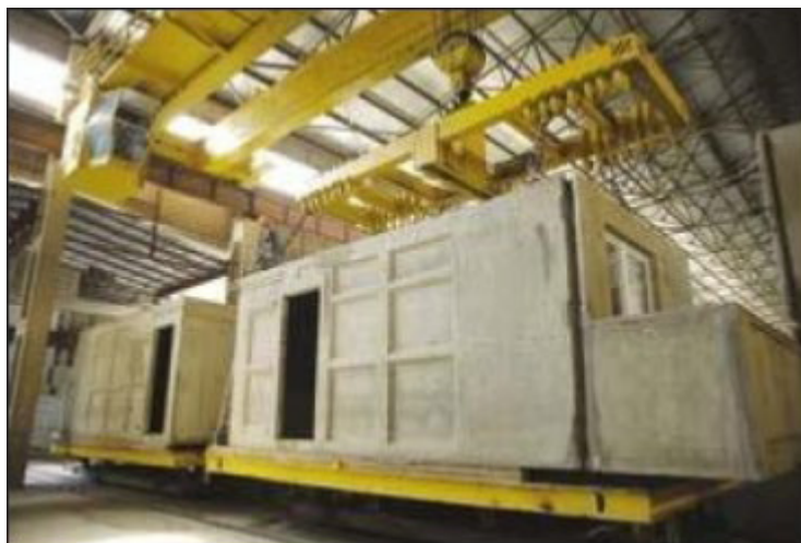
Рис.2. Вывоз готового объемного блока на строительную площадку
