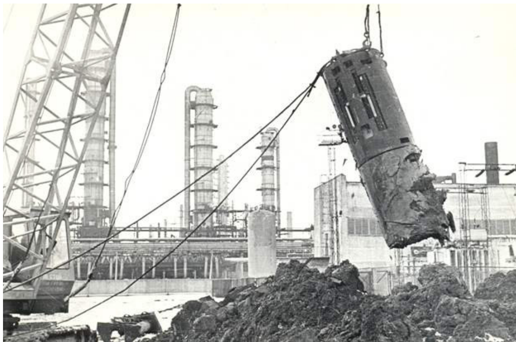
Рис. 3. Выгрузка грунта при производстве работ по горизонтальной проходке скважин ударно-вибрационным грейфером
