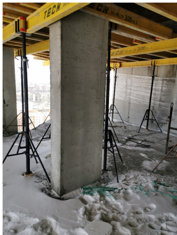
Рис. 8. Колонна сечением 300 \times 800 мм после распалубки
