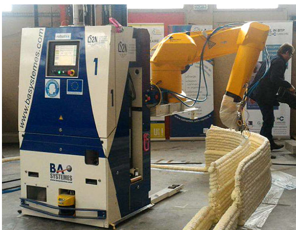
Рис. 3. Печать утепленной несъемной опалубки из пенополиуретана
