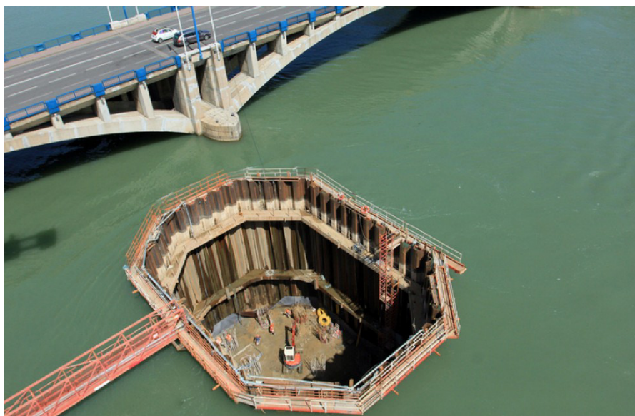
Рис. 2. Погружение коффердама в воду
