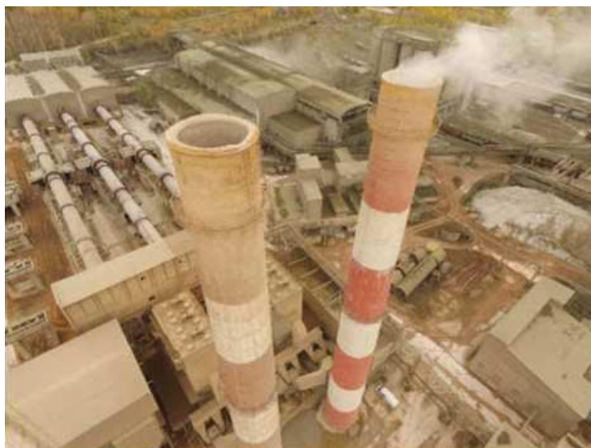
Рис. 3. Осмотр поверхности высотных объектов (дымовые трубы, силосы, завод в г. Пикалево) [8]
