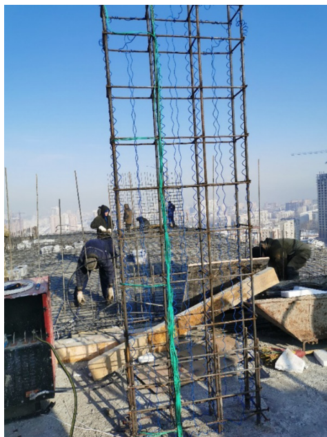
Рис. 4. Каркас колонны сечения 300 × 1200 мм Рис. 5. Каркас колонны сечения 300 × 800 мм
