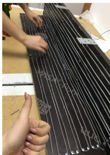
Рис. 2. Расположение греющего провода на внутренней поверхности опалубки
