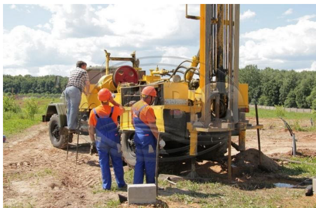
Рис. 5. Установка для бурения вертикальной скважины
