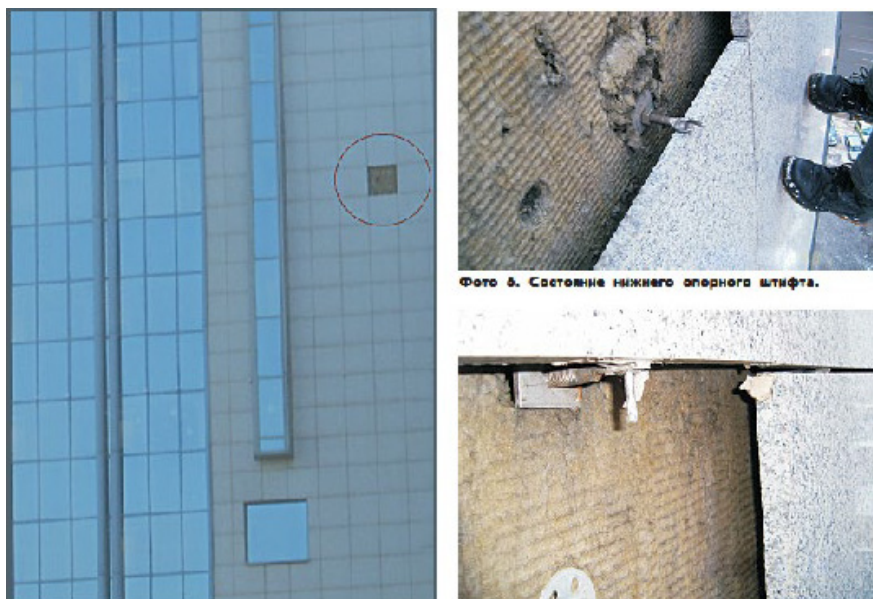
Рис. 4. Место падения гранитной облицовочной плиты, состояние верхнего и нижнего штифта
