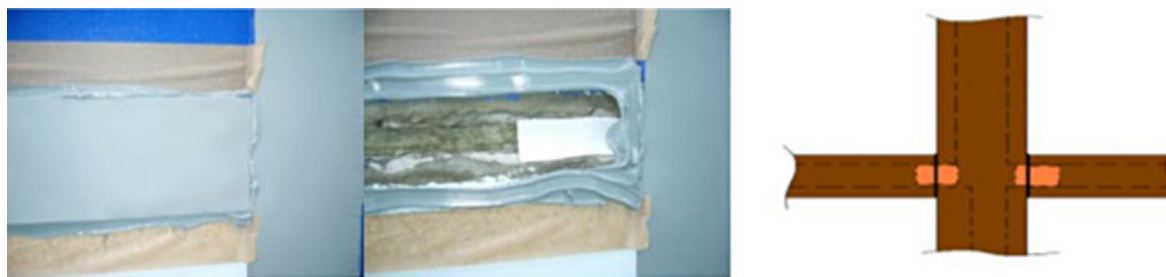
Рис. 8. Усиление места пересечения швов
