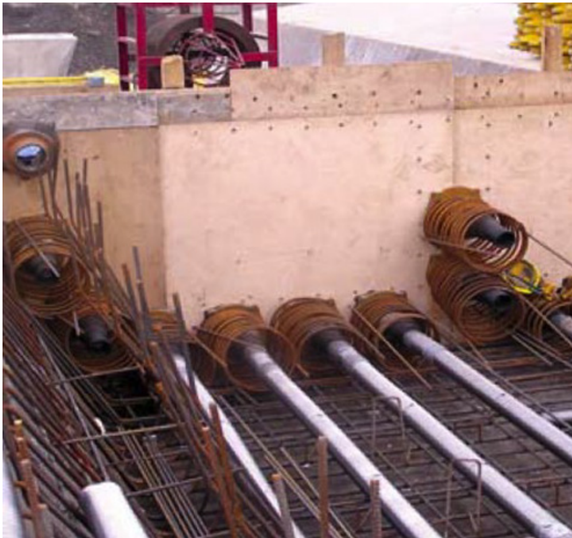
Рис. 4. Опорные стаканы и спирали косвенного армирования
