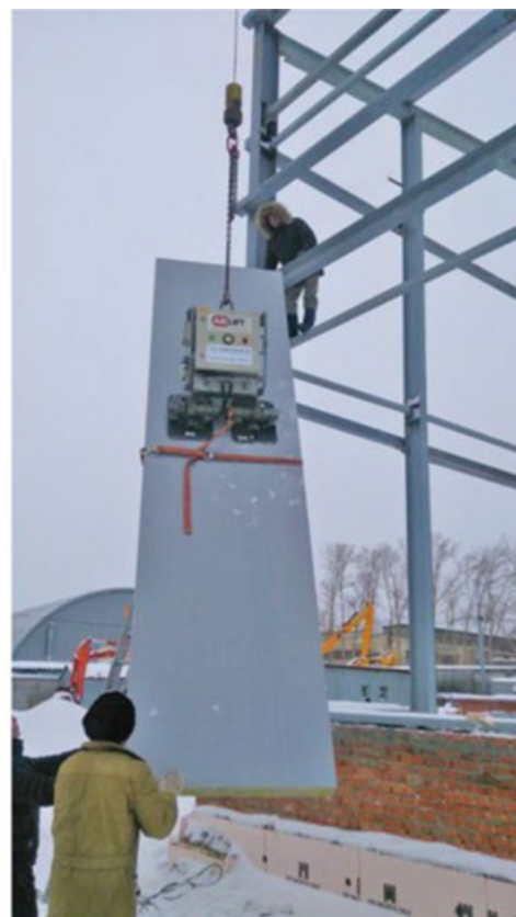
Рис. 11. Строповка сэндвич-панелей при вертикальной раскладке: а – схема строповки; б – монтаж панели
