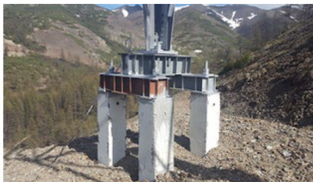
Выход свай в результате действия сил морозного пучения
