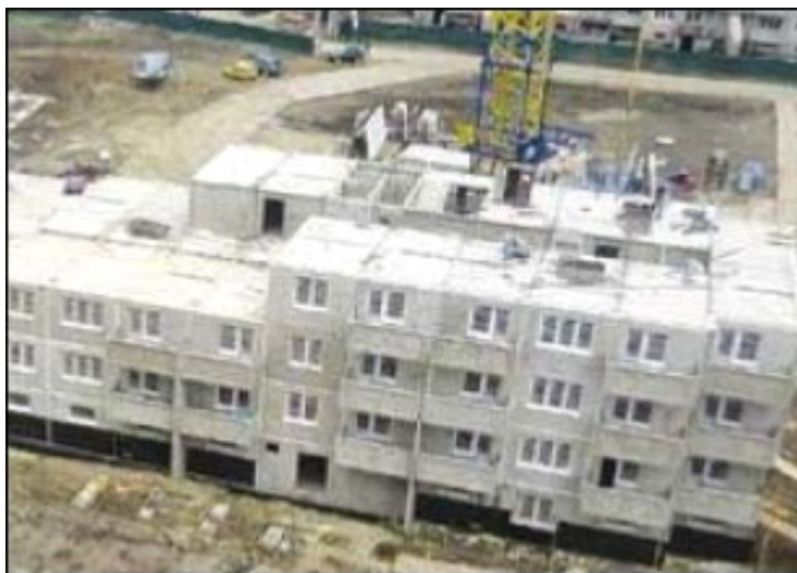
Рис. 1. Процесс монтажа жилого дома из объемных блоков
