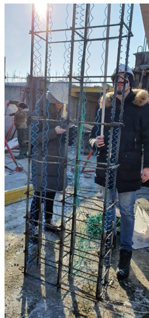
Рис. 4. Каркас колонны сечения 300 × 1200 мм Рис. 5. Каркас колонны сечения 300 × 800 мм
