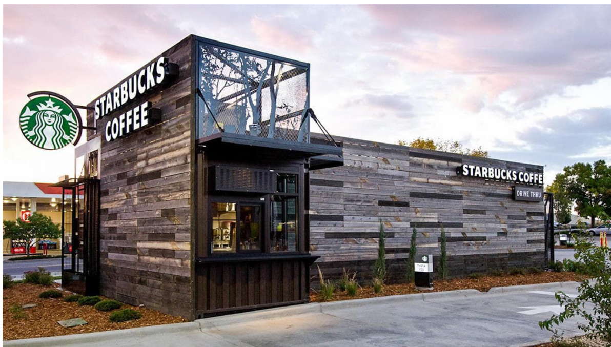
Рис. 2. Кофейня Старбакс из морских контейнеров
