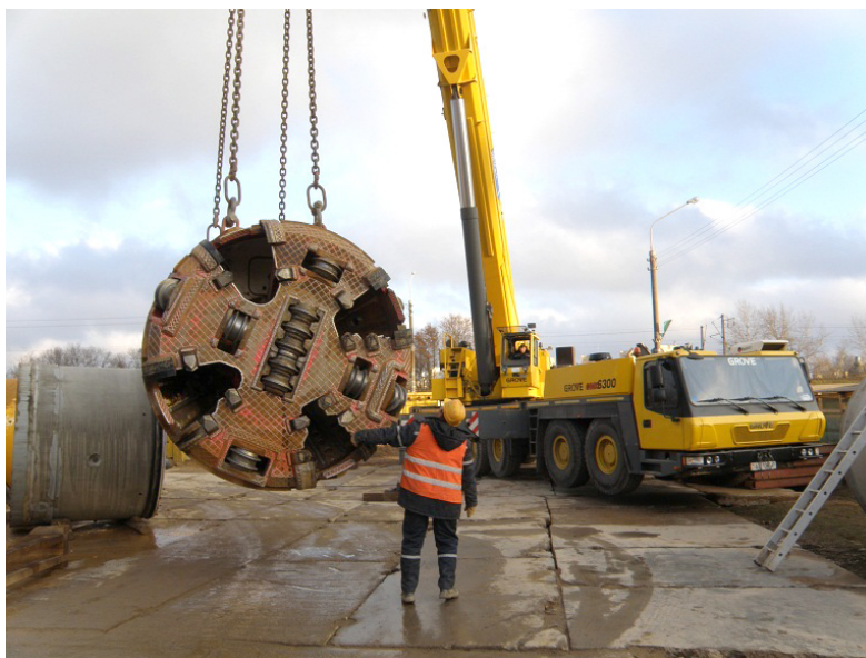
Рис. 4. Микропроходческий щит, используемый при микротоннелировании
