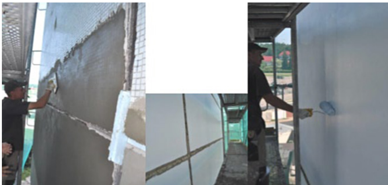
Рис. 6. Оштукатуривание и окрашивание паропроницаемыми составами
