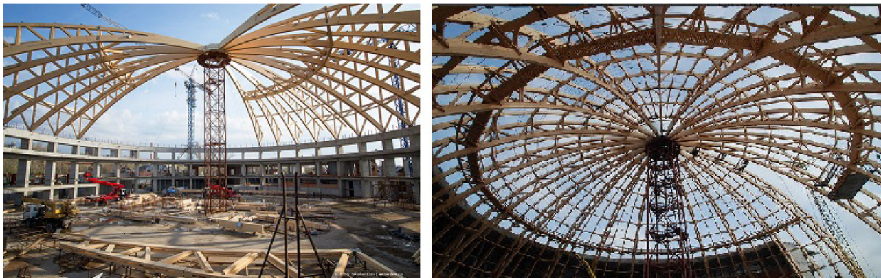
Рис. 2. Монтаж большепролетного покрытия ребристого купола а – монтаж решетчатых ферм ребер купола автокраном; б – завершающий этап монтажа ребер купола
