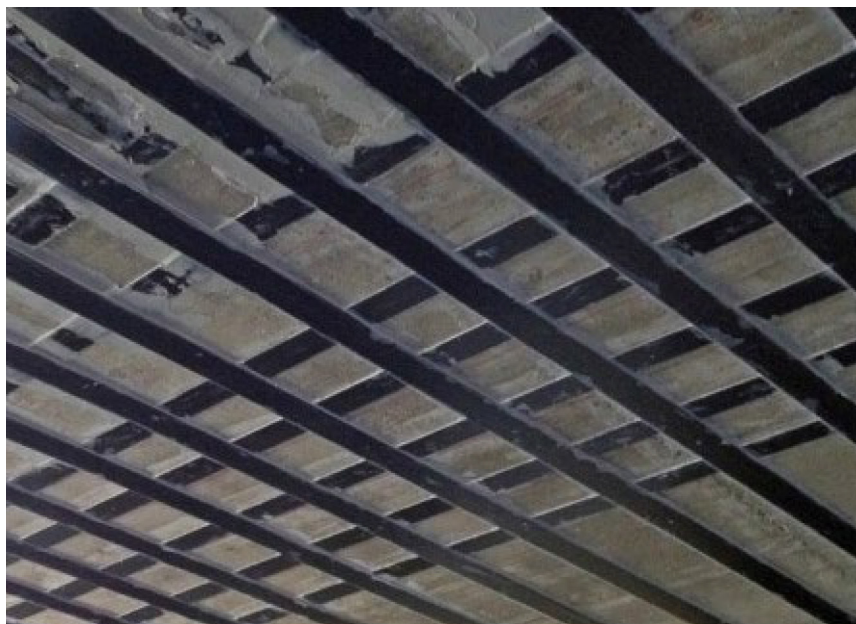
Рис. 4. Армирование плит покрытий углеродным волокном
