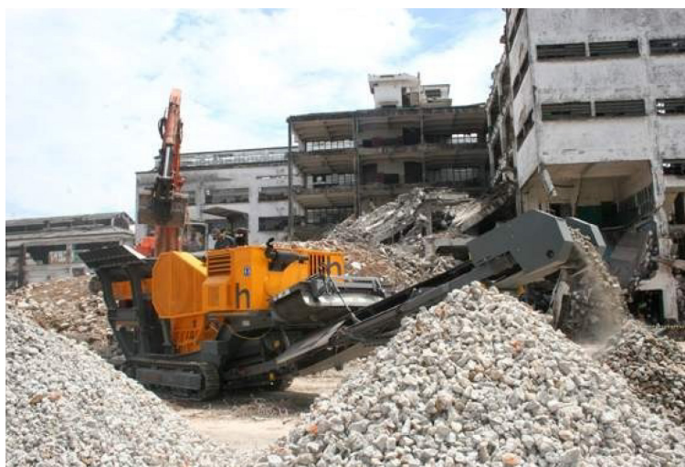
Рис. 6. Переработка бетона на строительной площадке с помощью мобильной установки
