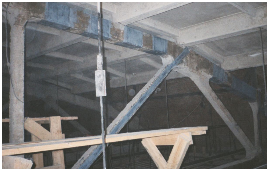
Рис. 3. Армирование ферм углеродным волокном
