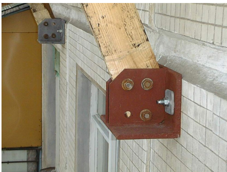
Рис. 3. Стальной крепежный элемент подвесных консольных лесов
