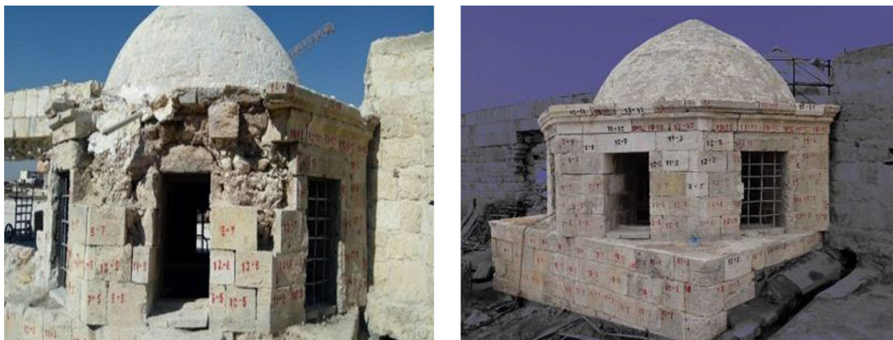
Рис. 7. Реставрационные работы каменных стен. Восстановлен каменный купол Макама, серьезно поврежденный снарядами
