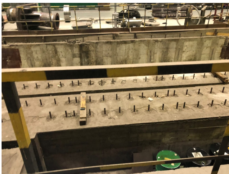
Рис. 1. Фундамент под горизонтально-расточной станок Juaristi модель TX3S-MGX40
