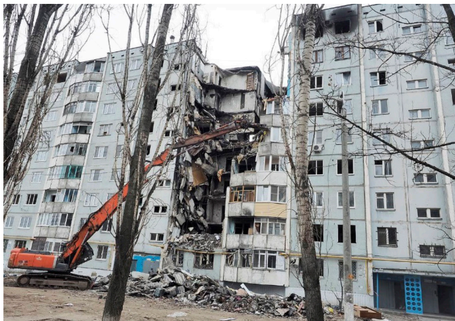
Рис. 3. Снос здания механическим методом
