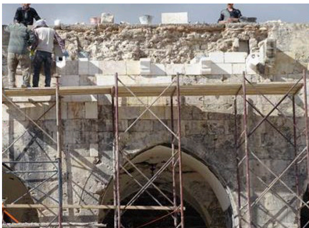
Рис. 4. До и после реставрации восточного портика путем очистки отверстий от шрапнели, заполнения металлическим раствором, заполнения известковым раствором и забивания фасадного камня
