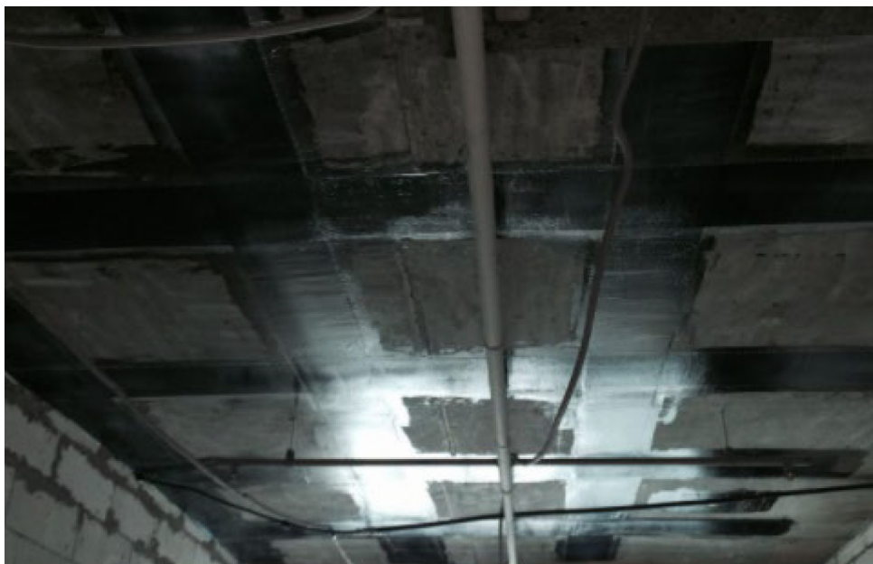
Рис. 5. Армирование плит покрытий углеродным волокном
