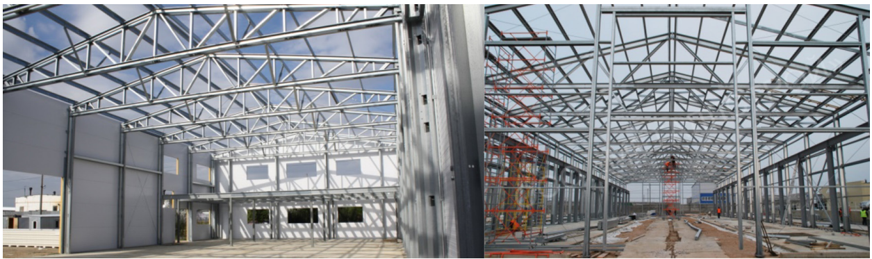
Рис. 2. Большепролетные сооружения промышленного назначения
