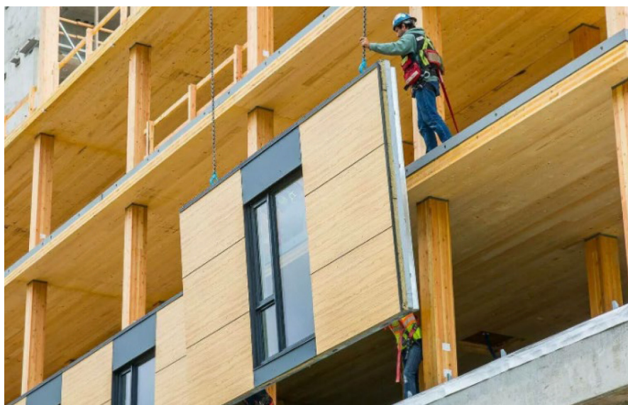
Рис. 7. Монтаж внешней стеновой CLT-панели
