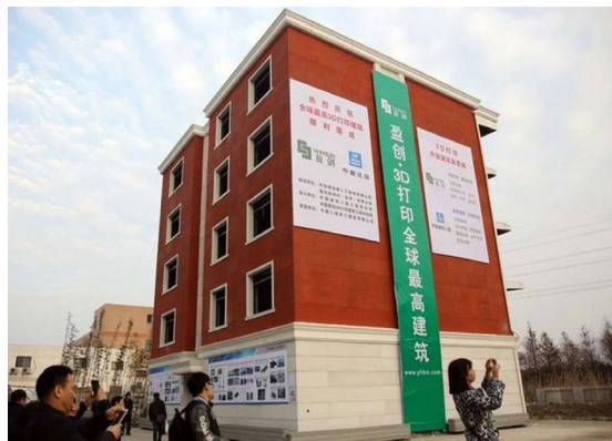
Рис. 1. Объект, построенный шанхайской компанией « WinSun » с помощью аддитивных строительных технологий
