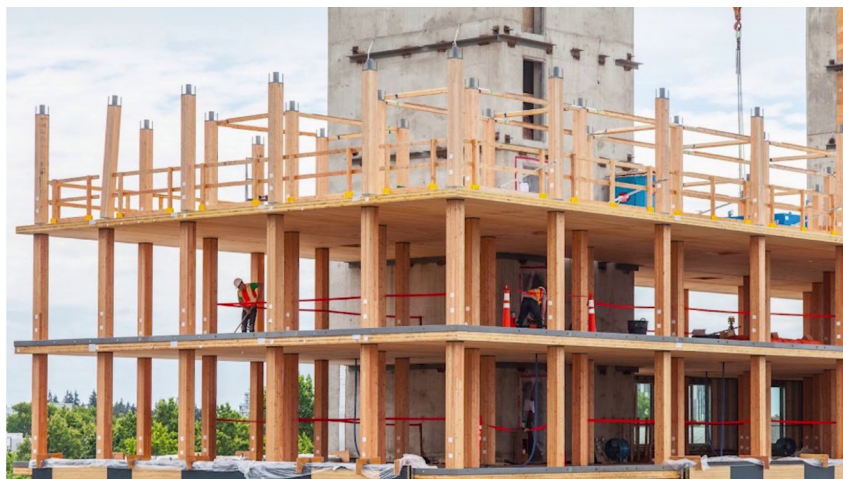
Рис. 9. Процесс сборки
