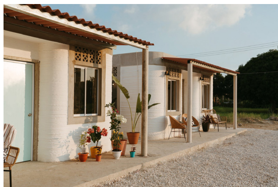
Рис. 2. Объекты, построенные тexasской компанией « ICON » с помощью аддитивных строительных технологий
