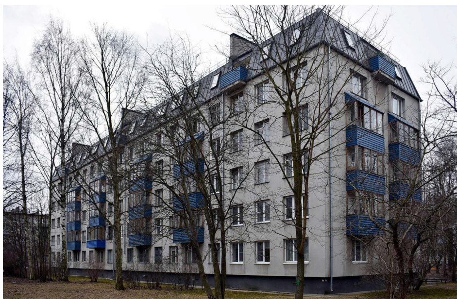
Рис. 1. Пилотный жилой дом, реконструированный с надстройкой этажа на Торжковской, 16
