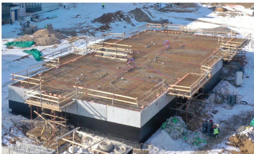
Рис. 2. Общий вид монтажного горизонта
