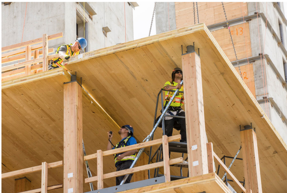
Рис. 8. Монтаж панелей перекрытия
