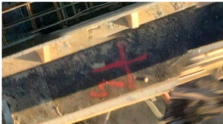
Рис. 3. Обозначение марки на монтажном горизонте
