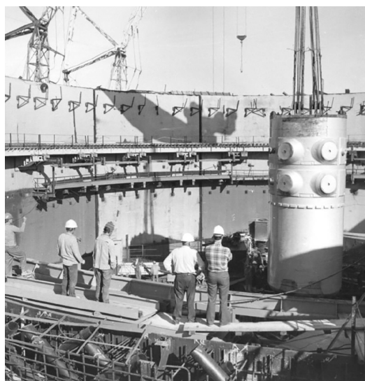
Рис. 1. Монтаж корпуса реактора на Балаковской АЭС
