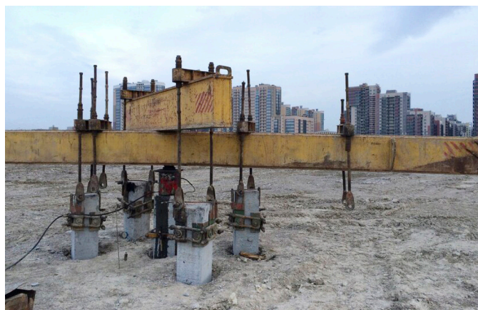
Рис. 1. Испытания грунтов статической вдавливающей нагрузкой при помощи анкерных свай
