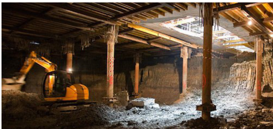
Рис. 3. Разработка грунта под плитой
