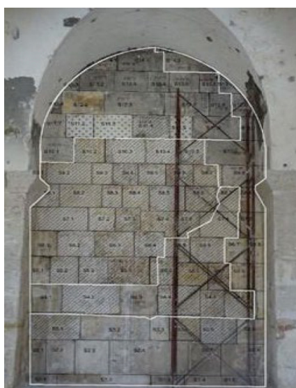
Рис. 5. Реставрационные работы в Кибле в мечети
