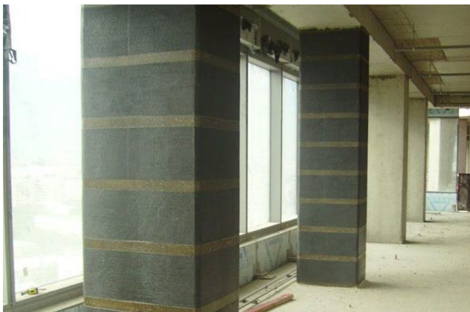
Рис. 2. Армирование колонн углеродным волокном
