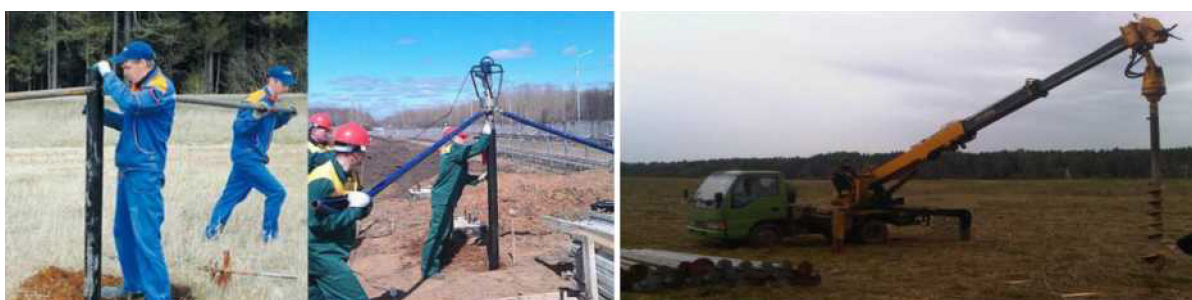
Рис. 9. Завинчивания винтовых свай вручную
