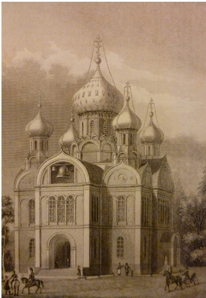
Рис. 2. Екатерининская церковь в Коломне у Калинкина моста. Гравюра по рисунку А. М. Горностаева [1, с.109]. Видно, что проём у звонницы уменьшен, и нагрузка с колокольной балки передаётся на простенки
