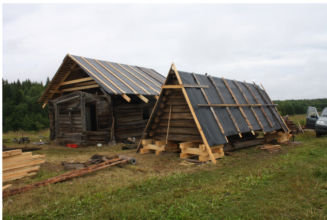
Рис. 2. Итог противоаварийных и консервационных работ 2015 г.
