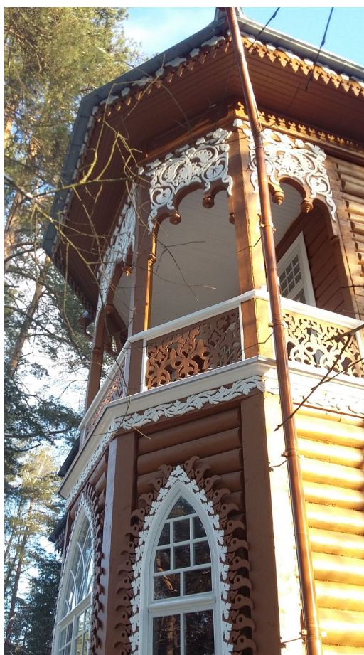
Рис. 6. Дача А.М. Юхневича в Комарово. Фрагмент фасада после реставрации. Фото из материалов ООО АКБ «ПетроГрадПроект». 2017 г.
