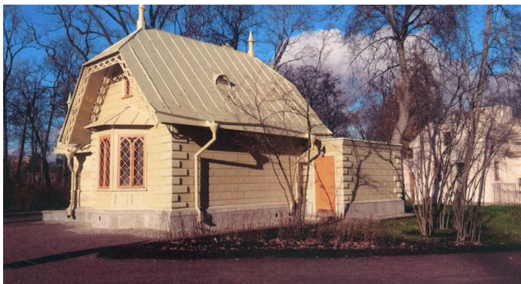
Рис. 4. Фельдъегерский домик в парке Александрия. Общий вид южного и восточного фасадов после реставрации. Фото из материалов ЗАО «Собор». 2013 г.
