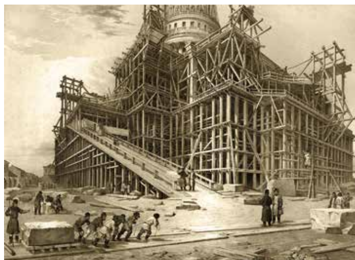
16, 17. Строительство Исаакиевского собора. Рис. О. Монферрана
