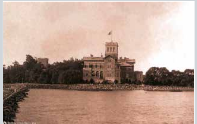
Рис. 5. Нижняя дача в Александрии. Вид со стороны канала. Видно расположение садовых ваз на бровке береговой дорожке. Слева от здания Нижней дачи – водонапорная башня служебного корпуса.
